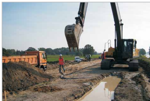
Abb. 2.2-13: Schlitzwandaarbeiten im Deich zwischen der Rampe „Sideram“ und der Rampe „Zwischendeich“ (Foto: LUGV)
