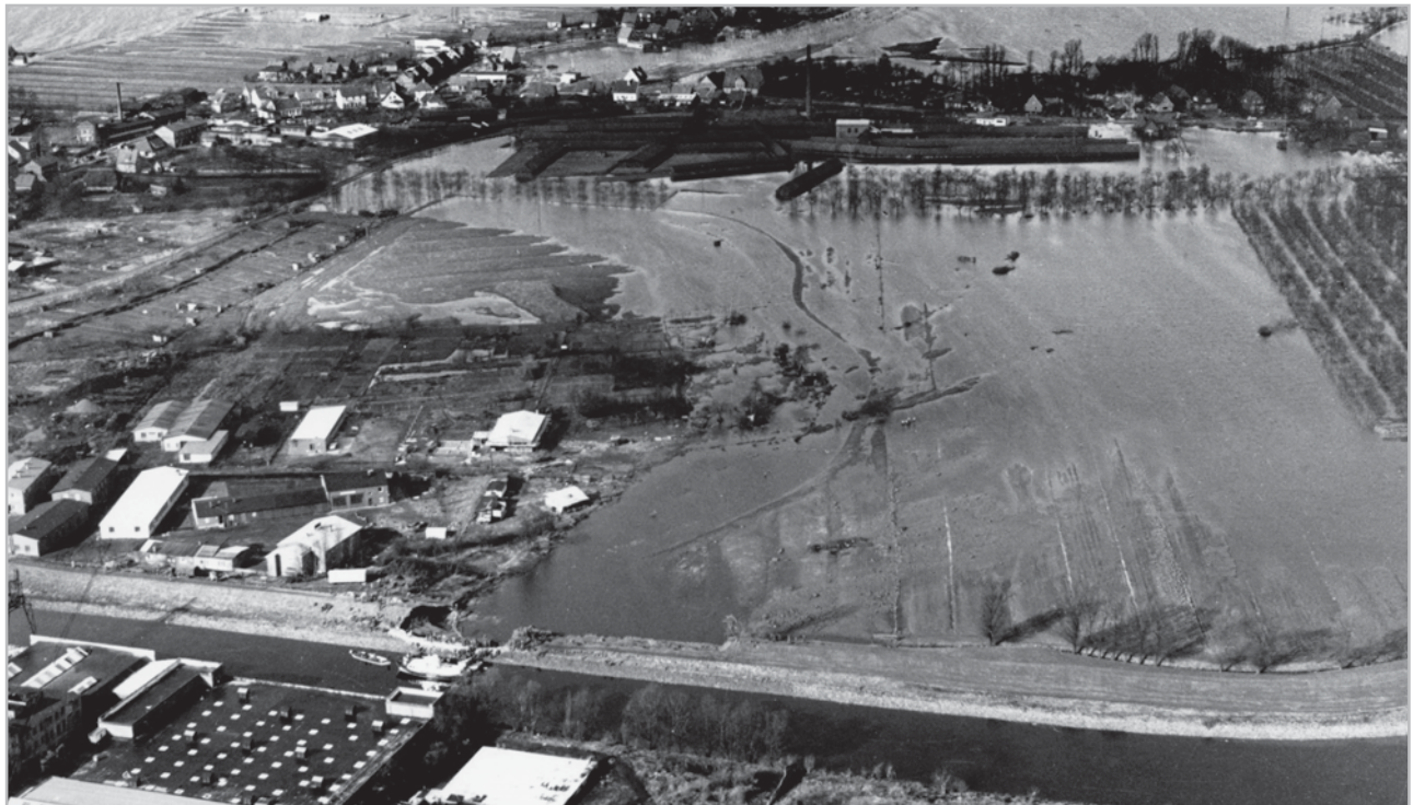
Abb. 4.2-4: Sturmflut 1962 – Deichbruch im Bereich Stade (Foto: NLWKN)
