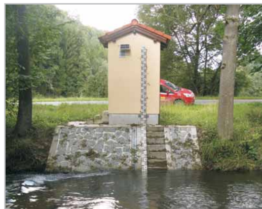
Abb. 3.3-3: Sanierter Pegel Chocnějovice am Flüsschen Mohelka (Foto: ČHMÚ)
