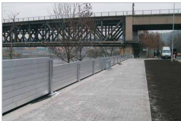
Abb. 2.2-4: Mobile Hochwasserschutzwand – Ústí nad Labem-Střekov (Foto: Povodí Labe, státní podnik)
