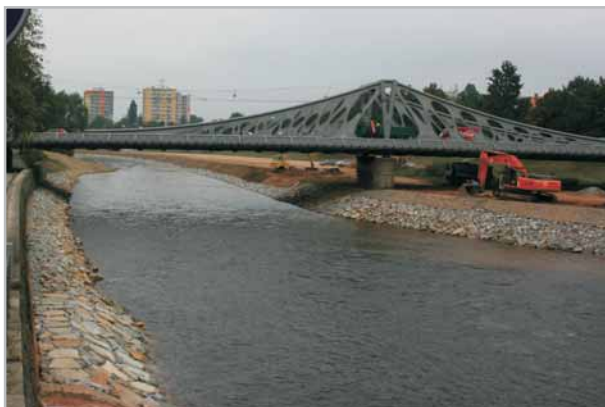
Abb. 2.2-1: Moldau – Ausbau des Gewässerbetts in České Budějovice (Foto: Povodí Vltavy, státní podnik)
