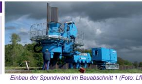
Einbau der Spundwand im Bauabschnitt 1 (Foto: LfU)
