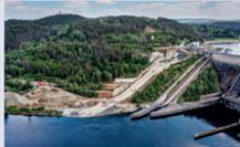
Bau der zusätzlichen Hochwasserentlastungsanlage der Talsperre Orlik (links) und Visualisierung der Endform (rechts) – Foto: Povodi Vltavy, státní podnik
