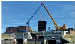
Einbau Stemmter Ilmenau-Sperrwerk (Foto: Stefan Löhn, NLWK/N)
