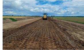
Herstellung des Deichkerns und der wasserseitigen Dichtung (Foto: LHW)
