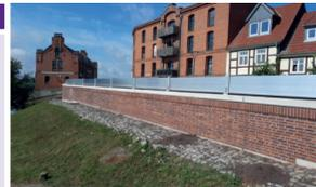
Hochwasserschutzwand mit aufgebauten mobilen Hochwasserschutzwänden (Foto: LfU)
