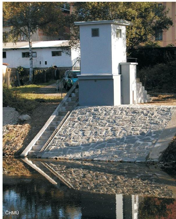
Abb. 4.2-1: Sanierte Pegel – Kaplice an der Malše (oben) und Sušice an der Otava (unten)
