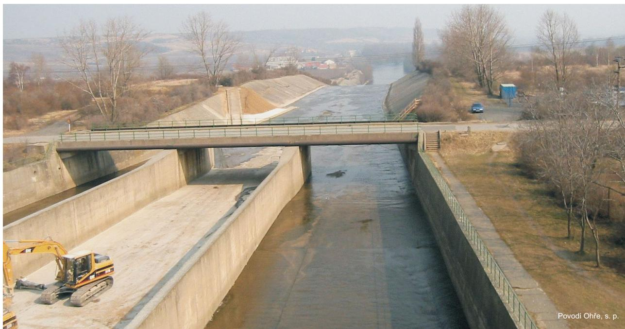
Abb. 3.1-1: Hochwasserüberlauf an der Talsperre Nechanice an der Elbe
