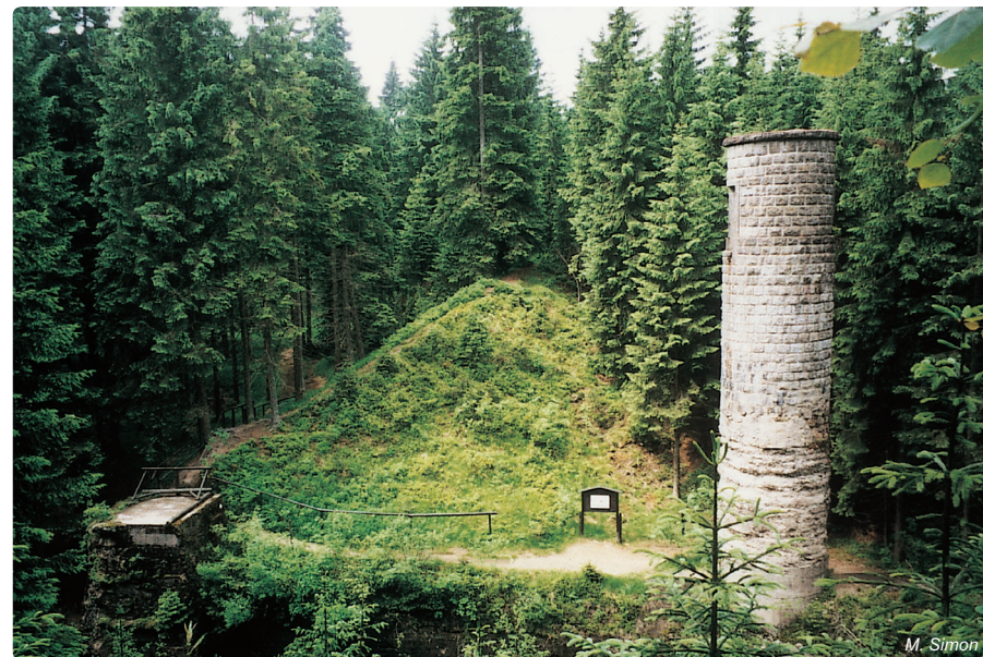
Abb. 4.1-18: Reste des 1916 zerstörten Erddamms der Talsperre Bílá Desná und des Grundablasses mit Schieberschacht und Auslaufbauwerk
