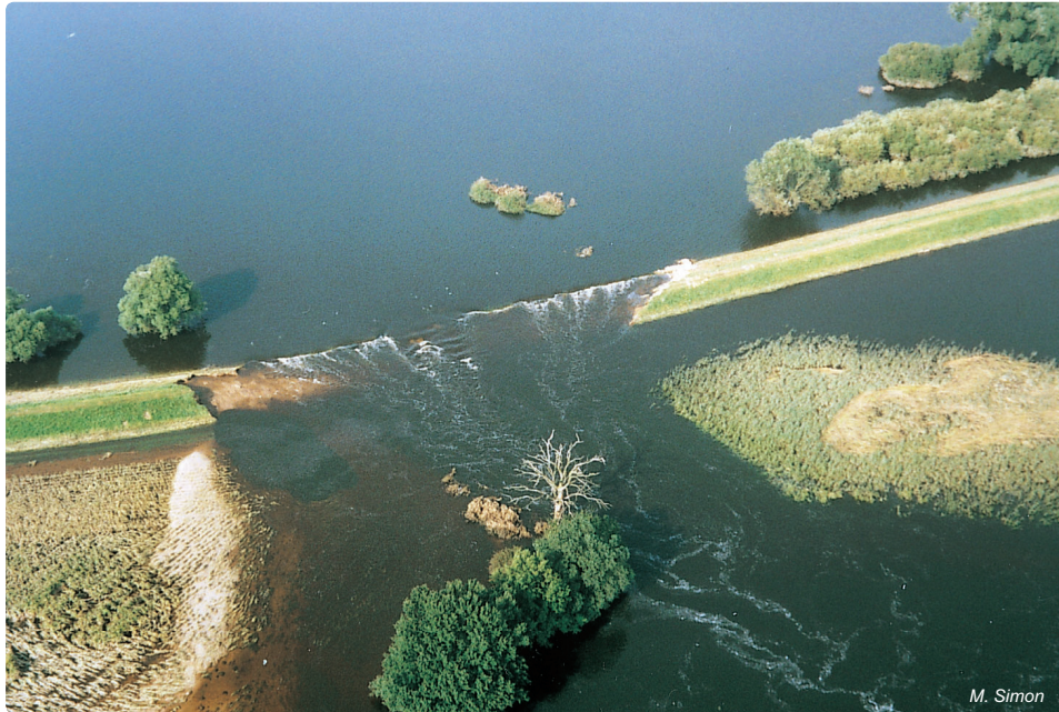
Abb. 4.8-10: Deichbruch bei Seegrehna unterhalb Wittenberg/L.
