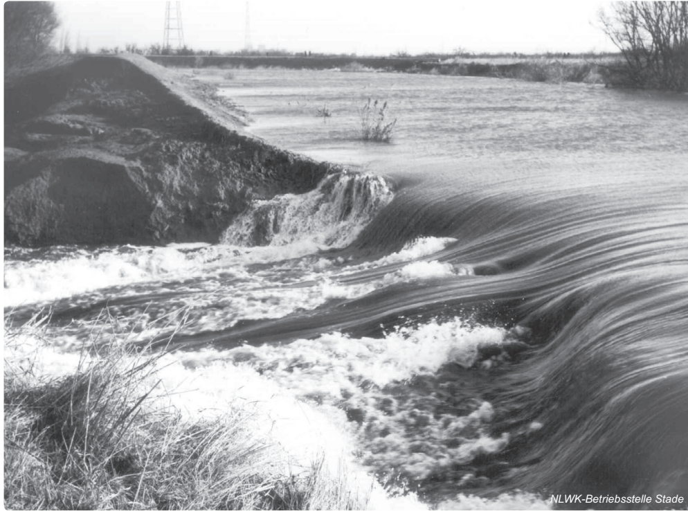
Abb. 3.1-2: Deichbruch am linken Schwingedeich bei Stade während der Sturmflut am 17.02.1962
