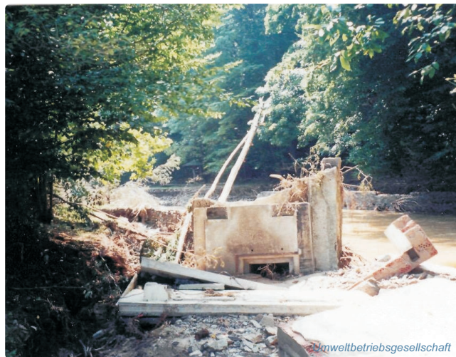
Abb. 5.1-15: Zerstörtes Pegelhaus am Pegel Hainsberg 1 an der Roten Weißeritz im Osterzgebirge
