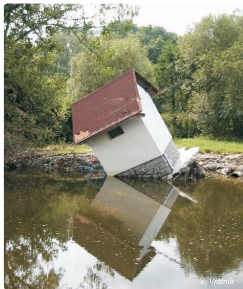
Abb. 5.1-14: Zerstörte Pegelanlage Žďirec an der Úslava im Einzugsgebiet der Berounka
