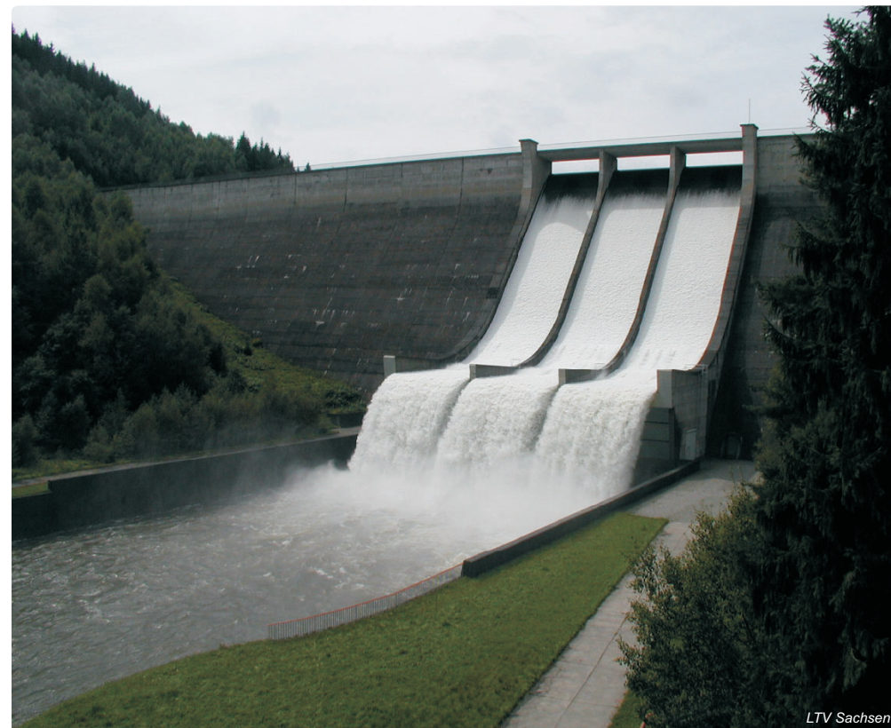
Abb. 3.3-16: Hochwasserableitung an der Talsperre Eibenstock mit 55 m 3 /s am 13.08.2002
