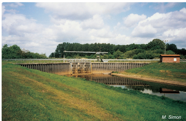
Abb. 4.10-17: Einlauf zum Düker der Löcknitz unter der Müritz-Elde-Wasserstraße
