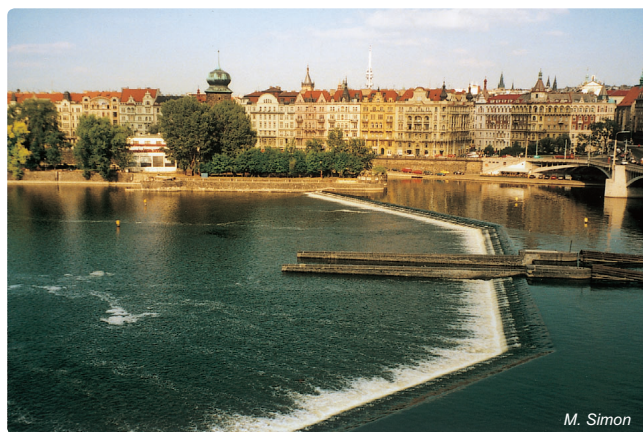
Abb. 4.2-27: Wehr Šitkov mit Floßdurchlass sowie Schleuse und mittelalterlichem Wasserturm „Mánes“ im Hintergrund
