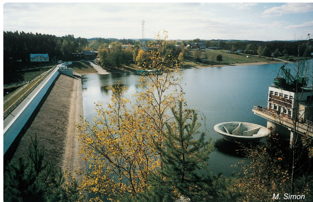
Abb. 4.2-25: Talsperre Hracholusky mit Kraftwerk und Schachtüberlauf
