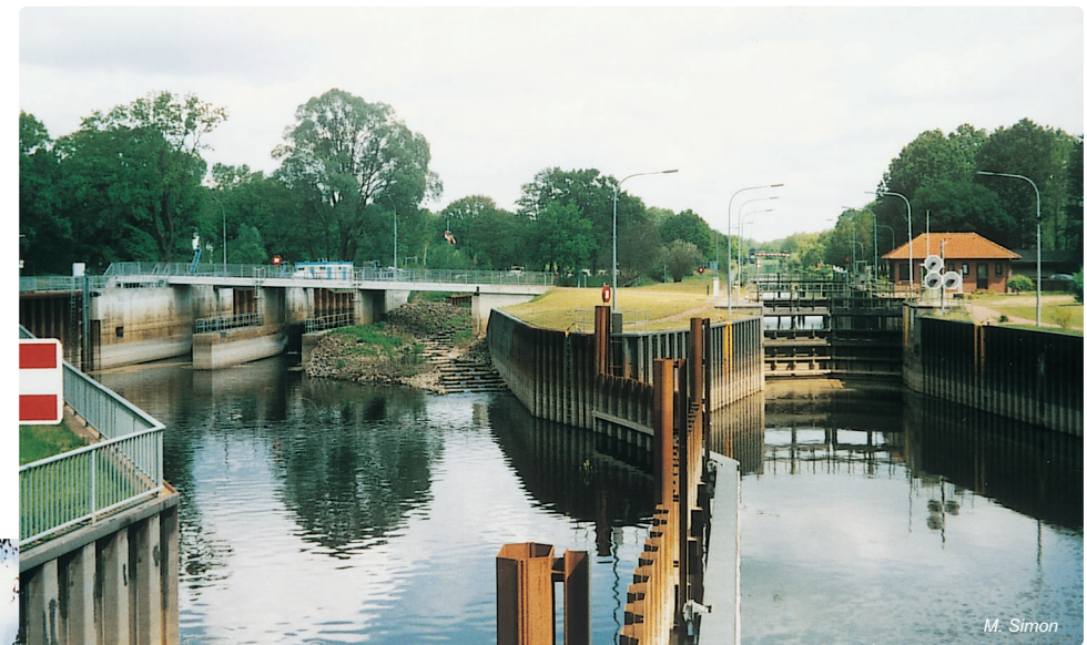
Abb. 4.10-16: Staustufe Dömitz mit Schleuse, Hochwasserentlastungswehr und Fischaufstiegsanlage
