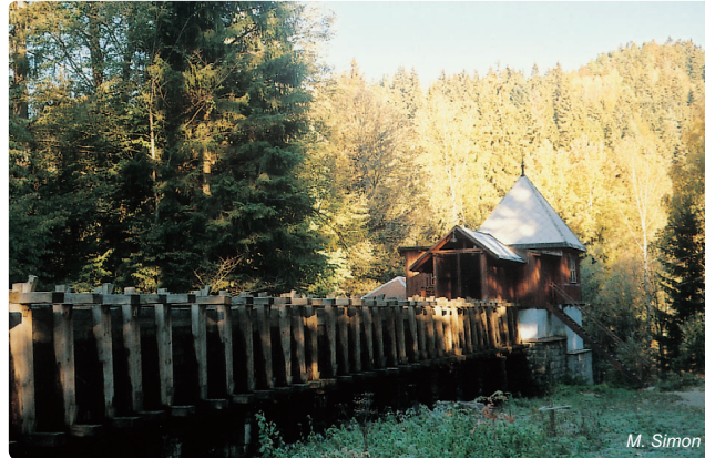
Abb. 4.2-18: Hölzerner Zuleitungskanal zum Kraftwerk „Čeňkova pila“, 105 m lang
