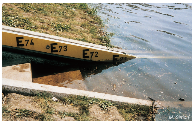
Abb. 5.1-9: Treppenpegel am Pegel Wittenberge/Elbe mit 714 cm Wasserstand. Der Höchststand betrug am 20.08.2002 – 734 cm.
