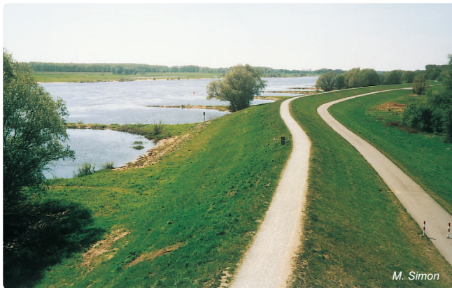
Abb. 4.10-6: Sanierter rechtsseitiger Elbedeich unterhalb Wittenberge
