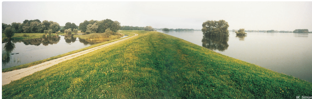
Abb. 3.1-15: Sanierter linksseitiger Elbedeich bei Neukirchen (unterhalb Werben, Elbe-km 436) mit den für diesen Elberaum typischen Qualmwasserpoldern am 24.08.2002
