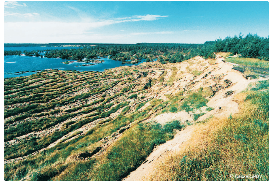
Abb. 4.9-27: Setzungsfließrutschung Tagebau Burghammer 1996
