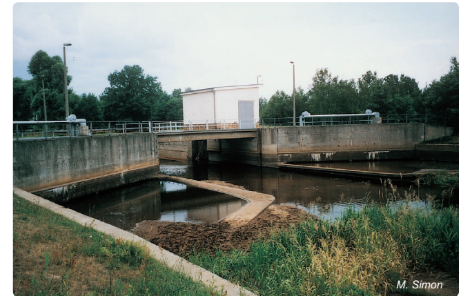
Abb. 4.5-9: Verteilerwehr in der Schwarzen Elster oberhalb Senftenberg mit Einlaufbauwerken in den Stollen zwischen den Speichern Koschen und Niemtsch
