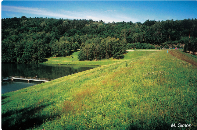
Abb. 4.4-18: Hochwasserrückhaltebecken Mordgrundbach mit Teildauerstau
