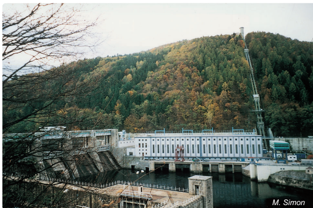
Abb. 4.2-12: Talsperre Štěchovice mit Laufkraftwerk (links) und Pumpspeicher-Kraftwerk (rechts)
