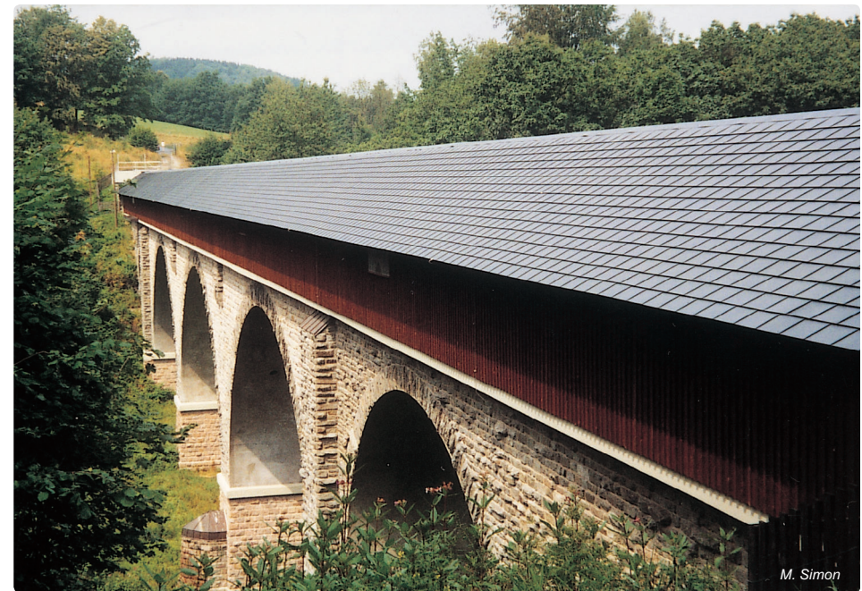
Abb. 4.6-8: Rekonstruierte Rohrbrücke über die Zschopau bei Waldkirchen
