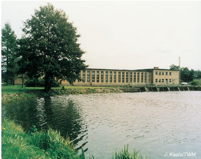
Abb. 4.8-27: Pumpstation Satuelle mit dem vorgelagerten Einlaufbecken (35 000 m 3 )
