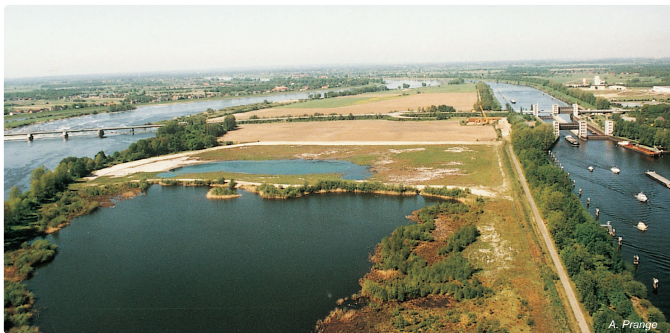
Abb. 4.10-22: Staustufe Geesthacht mit Wehr (links) und Schleusenanlage
