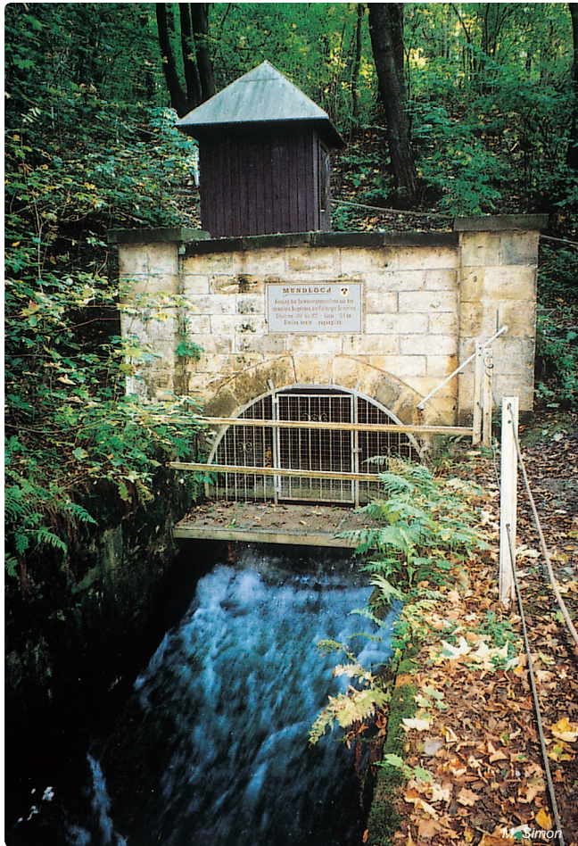
Abb. 4.6-9: Mundloch des Rothschönberger Stollens mit Abfluss in die Triebisch
