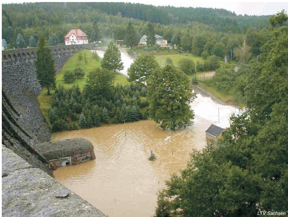
Abb. 3.3-15: Hochwasserableitung an der Talsperre Klingenberg mit 170 m 3 /s am 13.08.2002
