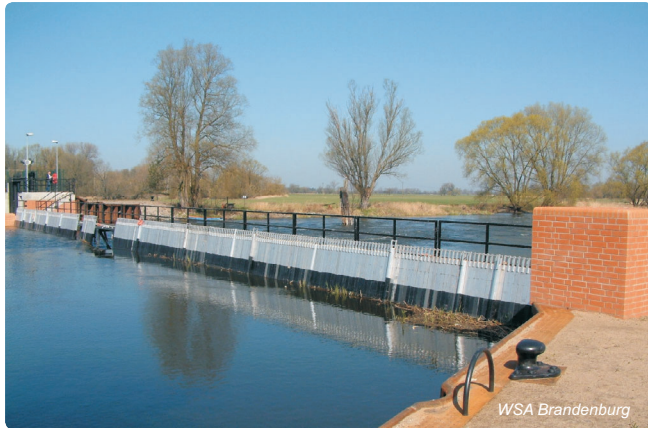
Abb. 4.9-35: Rekonstruiertes Nadelwehr in Garz
