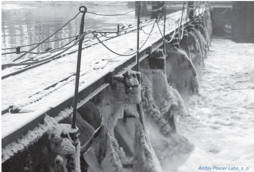
Abb. 5.3-2: Ehemaliges Nadelwehr in Lovosice mit starker Vereisung (Elbe-km 60,1)
