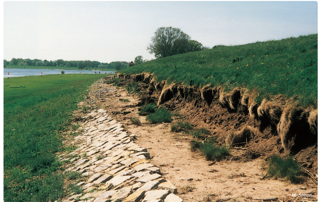
Abb. 5.3-13: Deichschäden am rechten Elbedeich mit vorgelagertem Deckwerk oberhalb Müggendorf (Elbe-km 464) infolge des Eisganges im Januar 2003
