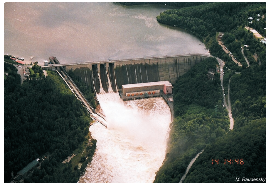
Abb. 3.3-11: Hochwasserableitung von 3 100 m 3 /s an der Talsperre Orlik am 14.08.2002
