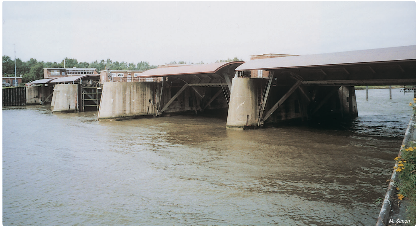
Abb. 3.1-8: Sturmflutsperrwerk der Oste mit Schiffs- und vier Seitenöffnungen
