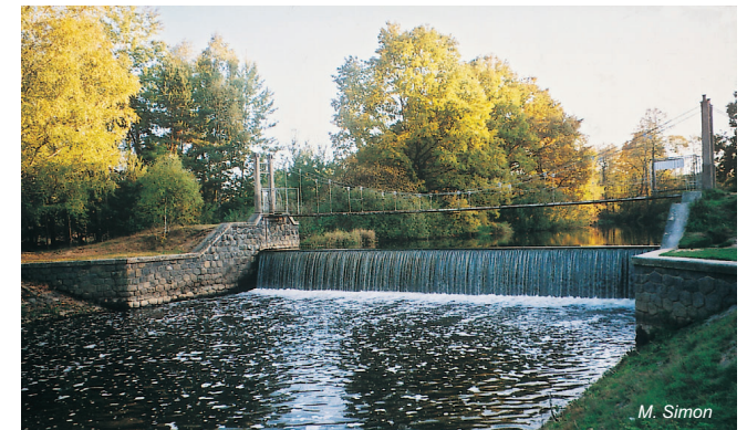
Abb. 4.2-15: Verteilerwehr in der Lužnice zur Ableitung von Wasser in den Kanal „Zlatá stoka“
