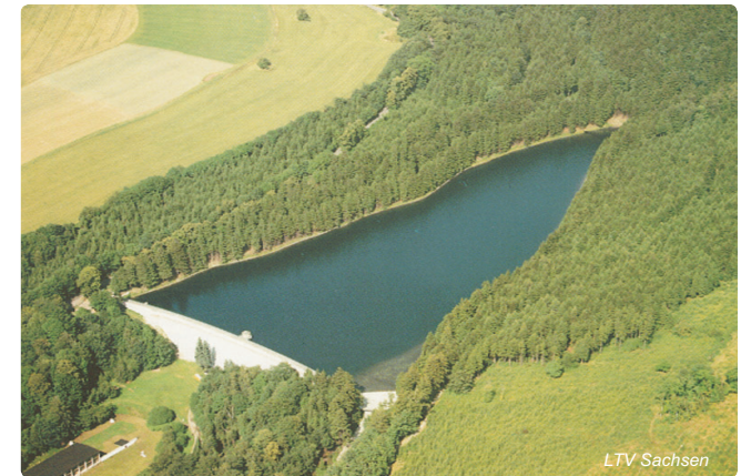
Abb. 4.6-7: Talsperre Einsiedel, zweitälteste Gewichtstaumauer Deutschlands
