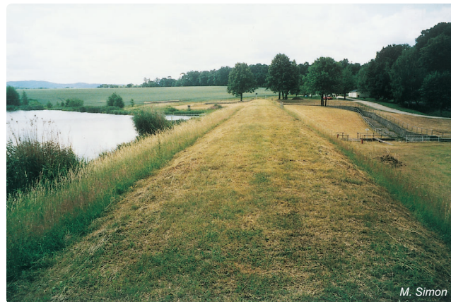
Abb. 4.5-4: Rückhaltebecken Göda (0,42 Mio. \text{m}^3 ) mit Teildauerstau
