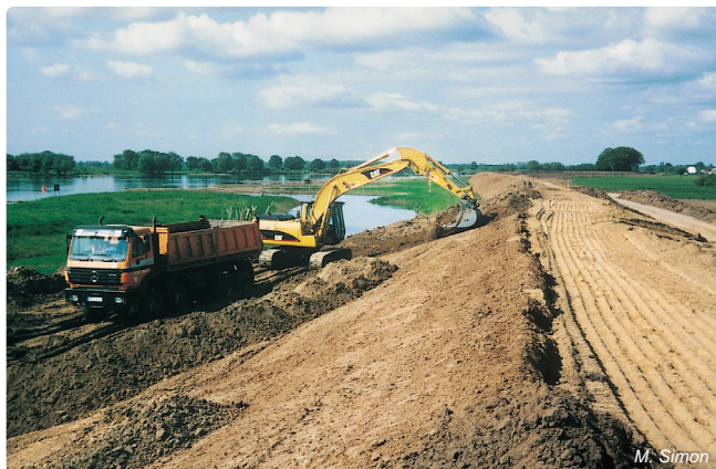
Abb. 3.1-14: Deichneubau des rechten Elbedeiches bei Jagel (Brandenburg) – Elbe-km 472 – im Jahre 2003
