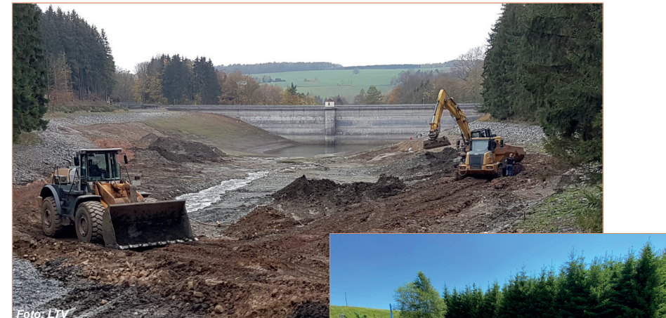
Talsperre Einsiedel: Sedimentberäumung nach Abstau 2017
