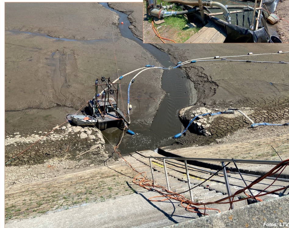
Sedimententnahme über Saugpumpen und anschließende Entwässerung mit GeoTubes (Kleines Bild) 2021
