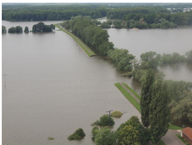
Abb. 3.7-13: Die Luftaufnahme vom 13. Juni 2013 zeigt die Bruchstelle des rechtsseitigen Saaledeichs bei Breitenhagen. Rechts unten ist das Schöpfwerk Breitenhagen zu sehen (Quelle: LHW ST)
