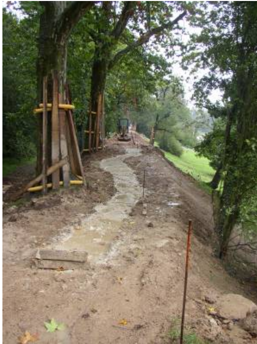
Abb. 2.2-2: Sanierungsarbeiten am Hochwasserschutzdeich im Wörlitzer Park (Foto: LHW – Frank Troger)
