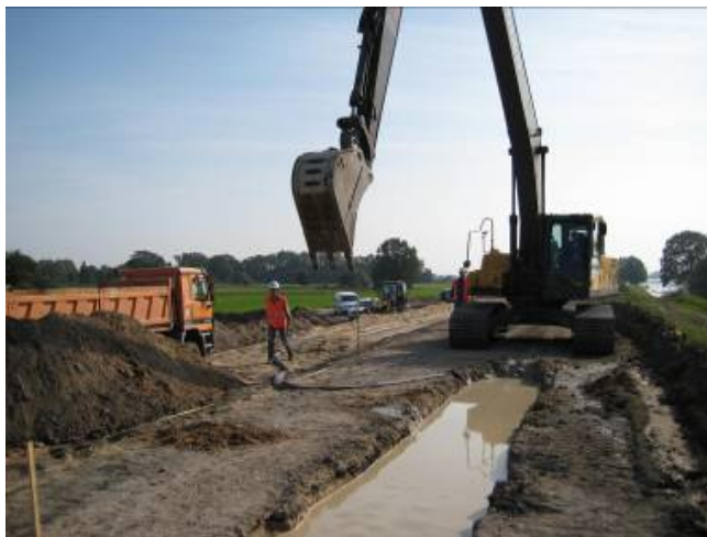
Abb. 2.2-5: Schlitzwandarbeiten im Deich zwischen der Rampe „Sideram“ und der Rampe „Zwischendeich“ (Foto: LUGV – Daniel Dahlke)
