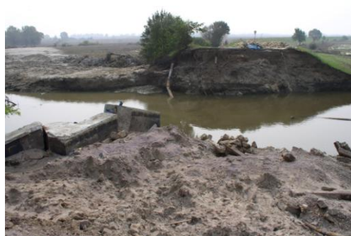
Abb. 3.2-7: Deichbruch Elbe-Umflutkanal (Quelle: Landesbetrieb für Hochwasserschutz und Wasserwirtschaft Sachsen-Anhalt)
