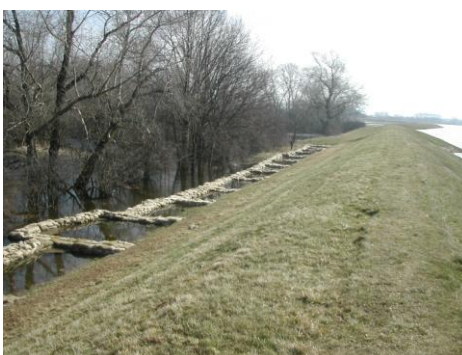
Abb. 4.3-6: Deichsicherung durch Sandsackverbau am Deich Prettin beim Hochwasser 2006 (Quelle: Landesbetrieb für Hochwasserschutz und Wasserwirtschaft Sachsen-Anhalt)
