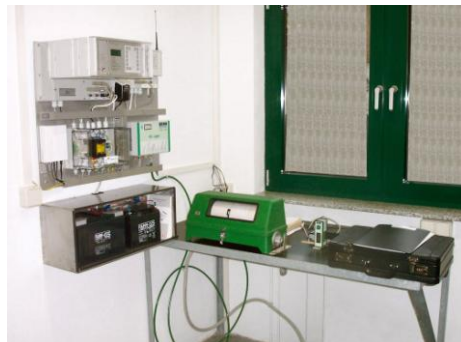
Abb. 4.2-3: Redundante Ausrüstung des Pegels Pegel Aue 3 an der Zwickauer Mulde (Quelle: Sächsisches Landesamt für Umwelt, Landwirtschaft und Geologie)
