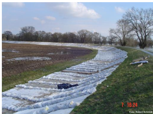
Abb. 3.2-10: Aprilhochwasser 2006, Rühstädter Bogen – landseitiger Sandsackverbau (Quelle: R. Schmidt, Landesumweltamt Brandenburg)
