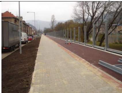
Abb. 3.1-6: Deichlinie mit mobiler Hochwasserschutzwand in Ústí nad Labem (Quelle: Povodí Labe, s. p.)
