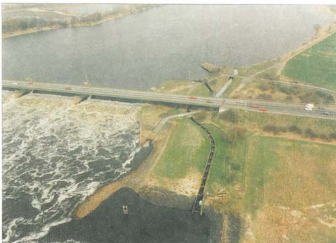
Abb. 9 Lage der beiden Fischaufstiegshilfen am linken Ufer am Wehr Geesthacht
