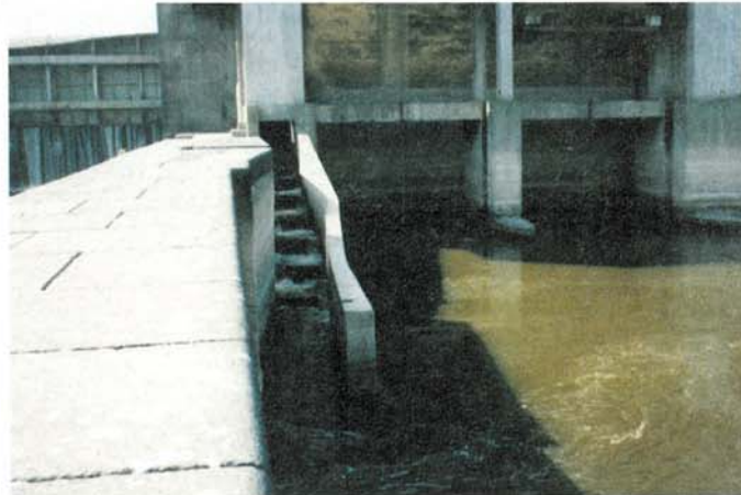
Abb. 19 Eingang in die Fischaufstiegshilfe vom Unterwasser an der Staustufe Strékov
