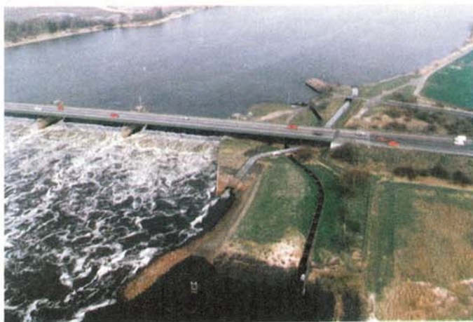
Abb. 18 Blick auf die beiden Fischaufstiegshilfen am Wehr Geesthacht
