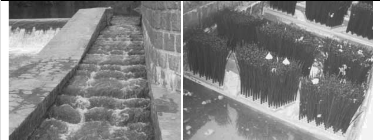
Obr. 1: Jez Černé Budy – pohled na RP a detail konstrukce (Weir Černe Budy, fish pass and detail of construction)
