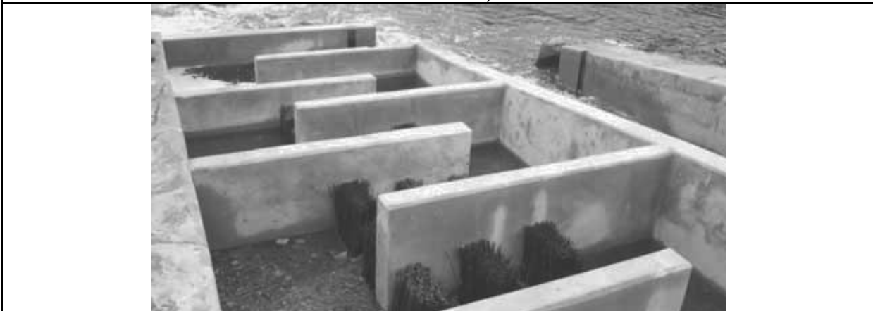
Obr. 2: Jez Kavalier, umístění štěrkové propusti uprostřed jezu a detail konstrukce RP (Weir Černé Budy, location of fish pass and detail of construction)
