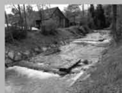
Soustava nízkých stupňů v korytě s rybím přechodem System of low bed drops with fish aids
