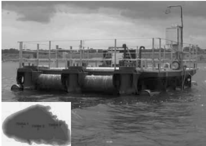
Fig. 1 Tiefenwasserbelüftungsanlage auf dem Runstedter See, links unten: Lage der Tiefenwasserbelüftungsanlagen
