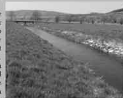
Souvislá úprava profilu, umělé napřiměný tok Continues river regulation, channel straightening
