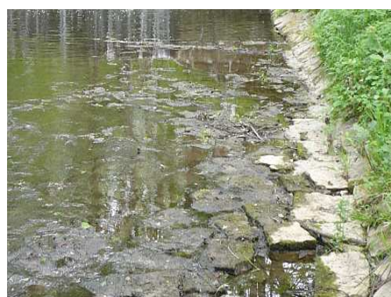
Zpevnění dna kamennou dlažbou.
