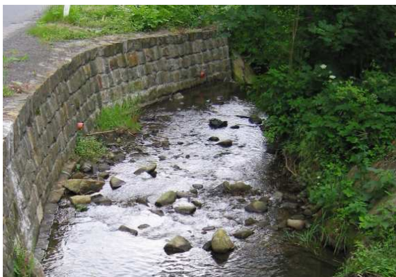
Zpevnění břehu kamennou dlažbou
