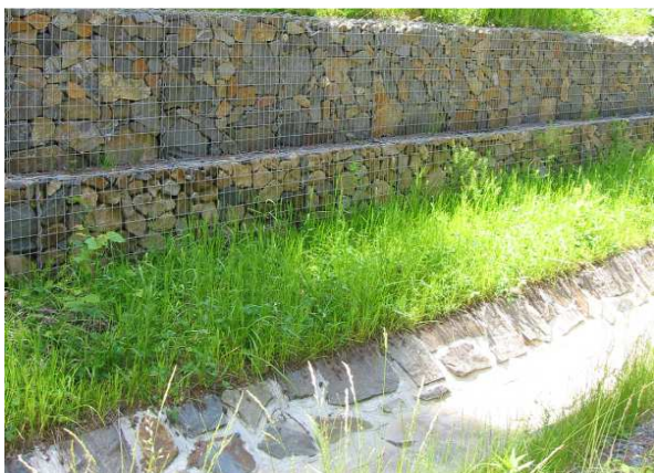
Gabiony na břehu koryta, koryto zpevněno kam.dlažbou
