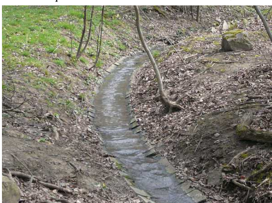
Zpevnění dna betonem – prefabrikované profily
