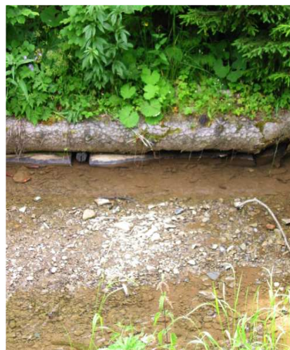
Vegetační opevnění břehu kulatinou
