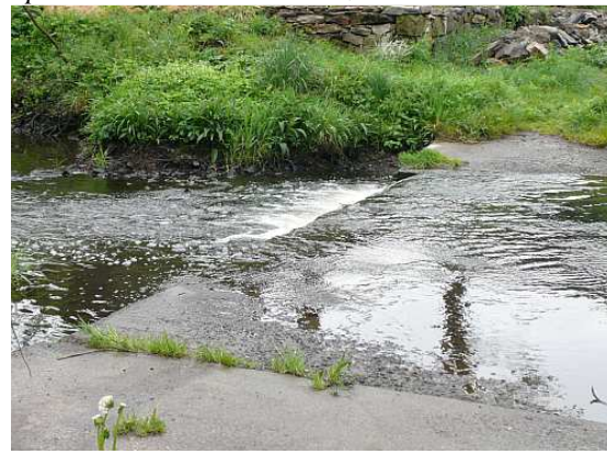
Zpevnění dna betonem – betonové desky
