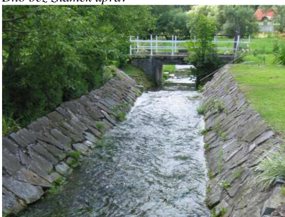
Souvislá úprava dna i břehů kamennou dlažbou
