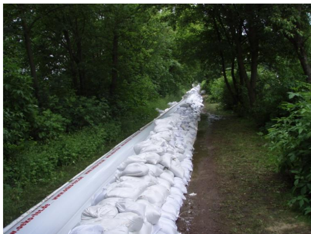
Obr. 3.7-11: Zabezpečovací práce na ochranné hrázi Gimritzer Damm ve městě Halle (zdroj: LHW ST)
