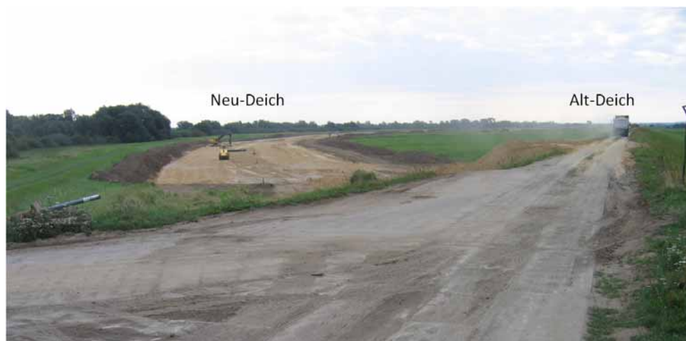
Obr. 2.1-6: Oddálení hráze Mahnkenwerder od toku (foto: STALU Westmecklenburg)
