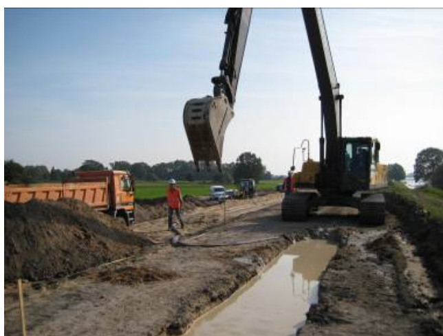
Obr. 2.2-5: Práce na podzemní stěně v ochranné hrázi mezi rampou „Sideram“ a rampou „Zwischendeich“ (foto: LUGV – Daniel Dahlke)
