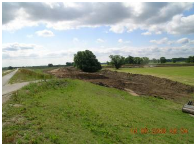
Obr. 2.1-3: Otevření staré hráze v roce 2009 - otvor č. 6 (foto: LUGV – Robert Schmidt)
