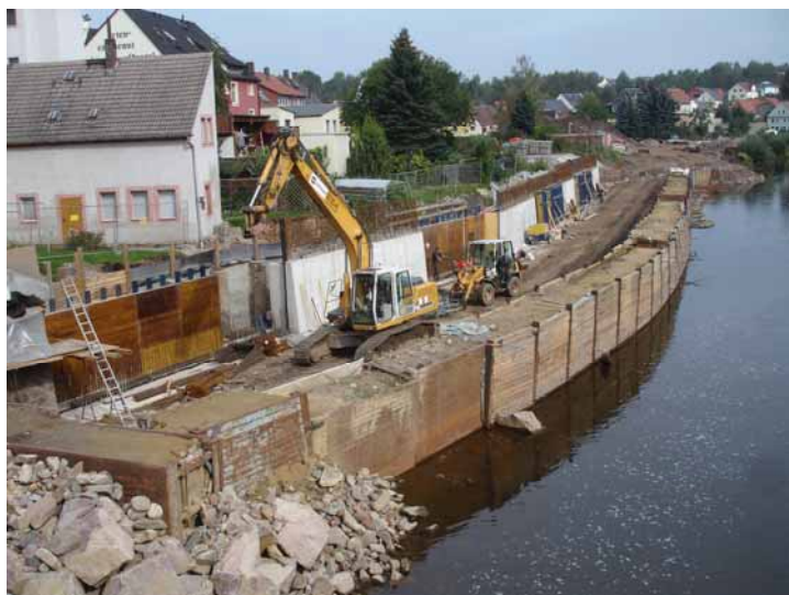
Obr. 2.2-1dt: Stavba protipovodňových opatření ve městě Penig na toku Zwickauer Mulde (foto: SMUL) – zatím chybí odkaz v textu
