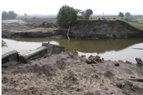
Obr. 3.2-7: Protřzená ochranná hráz na obtokovém kanálu Labe (zdroj: Zemský podnik povodňové ochrany a vodního hospodářství Saska-Anhaltska)
