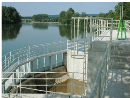
Obr. 3.1-4: Vodní nádrž Hvězda – dokončený bezpečnostní přeliv (zdroj: Povodí Labe, s. p.)
