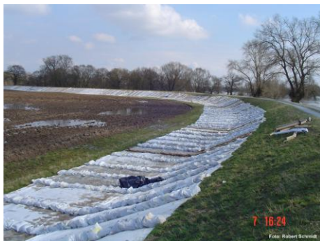
Obr. 3.2-10: Povodeň v dubnu 2006, říční ohyb u obce Rühstädt - hradba z pytlů s pískem na vzdušné straně hráze (zdroj: R. Schmidt, Zemský úřad životního prostředí Braniborska)
