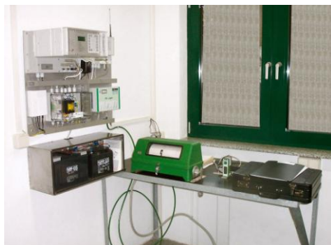
Obr. 4.2-3: Záložní vybavení vodoměrné stanice Aue3 na toku Zwickauer Mulde (zdroj: Saský zemský úřad životního prostředí, zemědělství a geologie)
