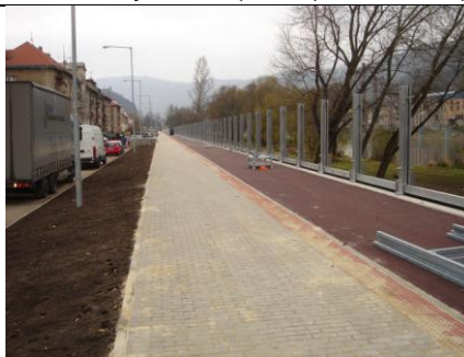
Obr. 3.1-6: Linie hrází s mobilním hrazením v Ústí nad Labem (zdroj: Povodí Labe, s. p.)
