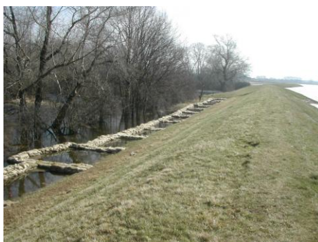
Obr. 4.3-6: Zabezpečovací práce na hrázi Prettin při povodni 2006 (zdroj: Zemský podnik povodňové ochrany a vodního hospodářství Saska-Anhaltska)
