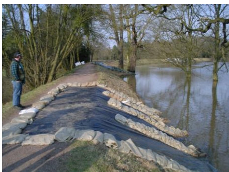
Obr. 4.3-5: Zabezpečení hráze v parku Wörlitz při povodni 2006 – Zahradní říše Dessau-Wörlitz je světovým dědictvím UNESCO (zdroj: Zemský podnik povodňové ochrany a vodního hospodářství Saska-Anhaltska)
