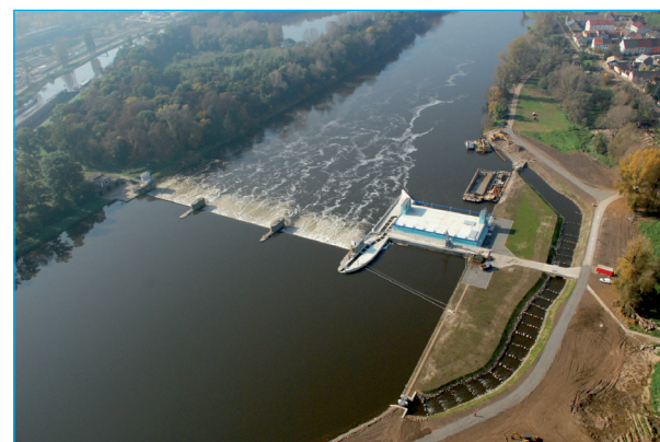
1 Výstavba balvanitého rybího přechodu u jezu Lovosice na Labi zdroj: Povodí Labe, státní podnik
