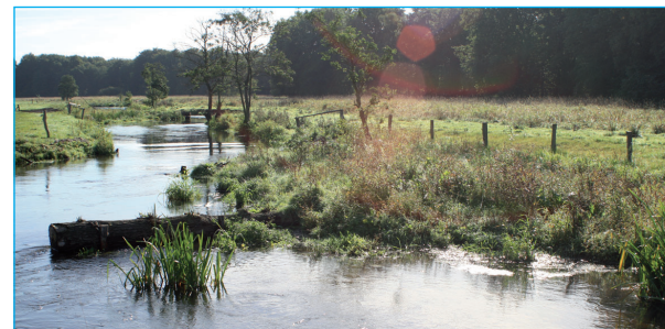
5 Prvky mrtvého dřeva jako usměrňovače proudu pro plánovitou erozi břehů řeky Stör zdroj: H.-J. Paulsen
