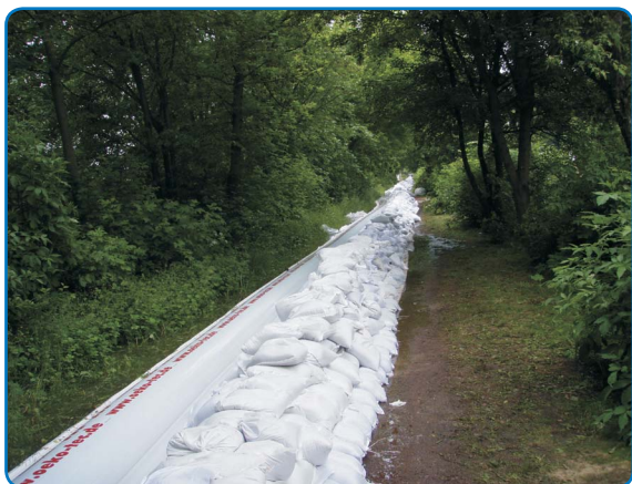
Obr. 3.7-12: Zabezpečovací práce na ochranné hrázi Gimritzer Damm na Sále ve městě Halle zdroj: LHW ST
