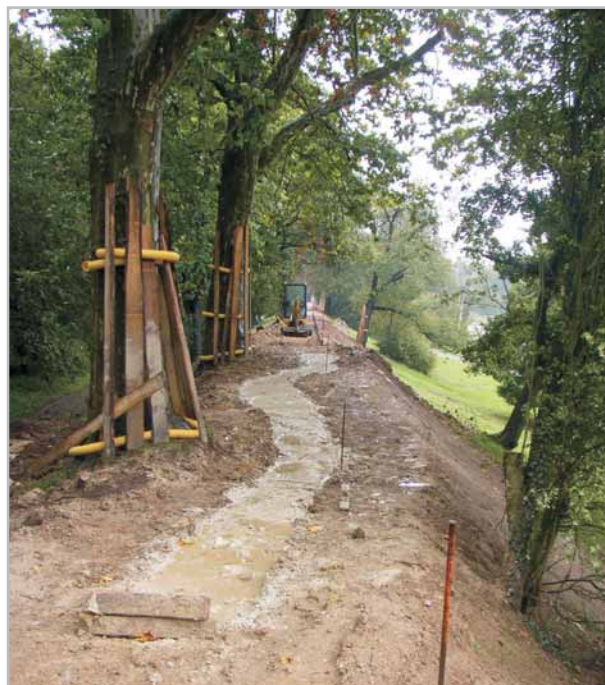
Obr. 2.2-9: Sanační práce na ochranné hrázi ve Wörlitzkém parku (foto: LHW)
