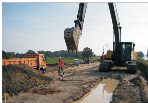
Obr. 2.2-13: Práce na podzemní stěně v ochranné hrázi mezi rampou „Sideram“ a rampou „Zwischendeich“ (foto: LUGV)
