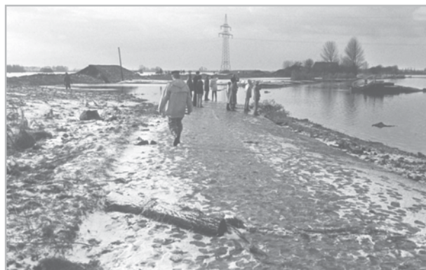
Obr. 4.2-3: Protřená ochranná hráz při bouřlivém přílivu v roce 1976 v oblasti Haseldorfer Marsch (foto: LKN)
