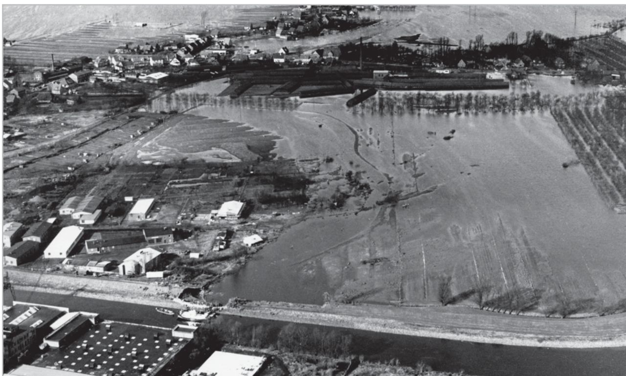
Obr. 4.2-4: Protřená ochranná hráz při bouřlivém přílivu v roce 1962 v oblasti města Stade (foto: NLWKN)
