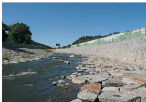
Obr. 2.2-2: Litávka (povodí Vltavy) – úprava koryta v Králově Dvoře (foto: Povodí Vltavy, státní podnik)
