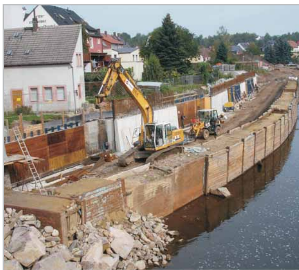
Obr. 2.2-8: Stavba protipovodňových opatření ve městě Penig na toku Zwickauer Mulde (foto: SMUL)
