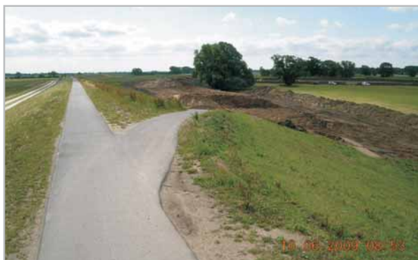
Obr. 2.1-7: Oddálení hráže od toku u obce Lenzen, otevření staré hráže v roce 2009 – otvor č. 6 (foto: LUGV)
