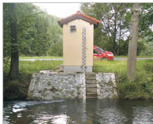
Obr. 3.3-3: Rekonstruovaná vodoměrná stanice Chocnějovice na říčce Mohelka (foto: ČHMÚ)
