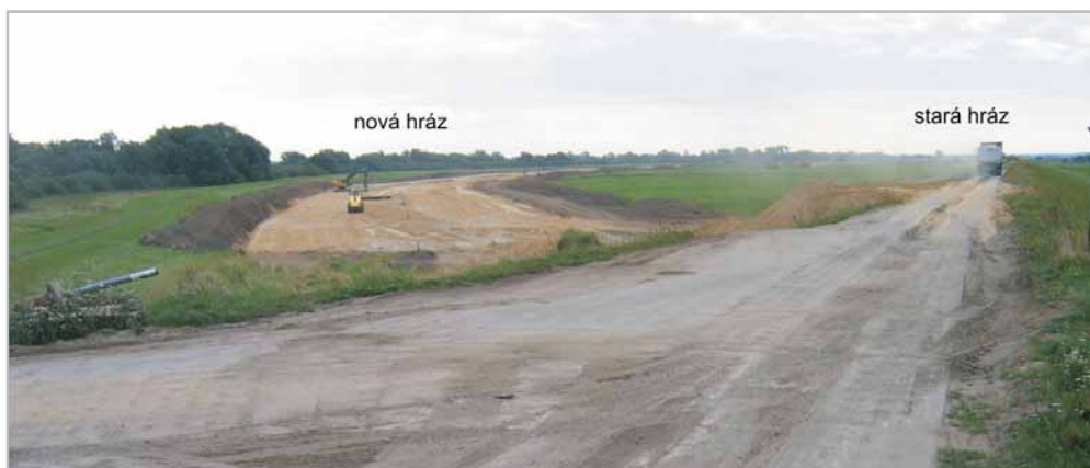
Obr. 2.1-10: Oddálení hráže od toku v lokalitě Mahnkenwerder (foto: StALU Westmecklenburg)
