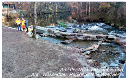
Rybí přechod u jezu Mahlerwinkel na potoce Braunaubach
