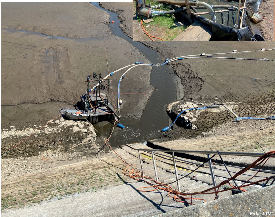
Dittmannsdorfský rybník (Dittmannsdorfer Teich): Odtěžení sedimentů sacími čerpadly a následné odvodnění v textilních vácích GeoTubes v roce 2021
