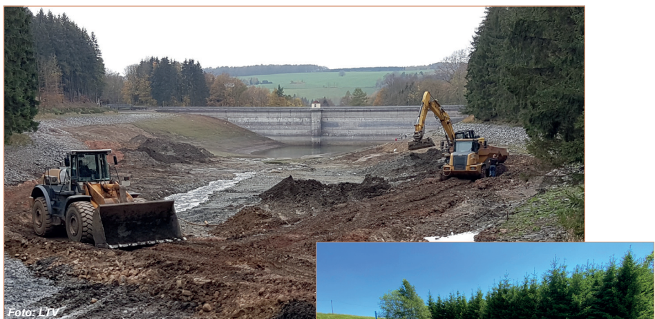
Vodní nádrž Einsiedel: Odtěžení sedimentů po vypuštění v roce 2017
