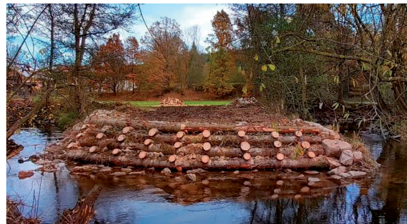
Reslava – stabilizace břehu srubovou konstrukcí (foto: Wasserwirtschaftsamt Hof)
