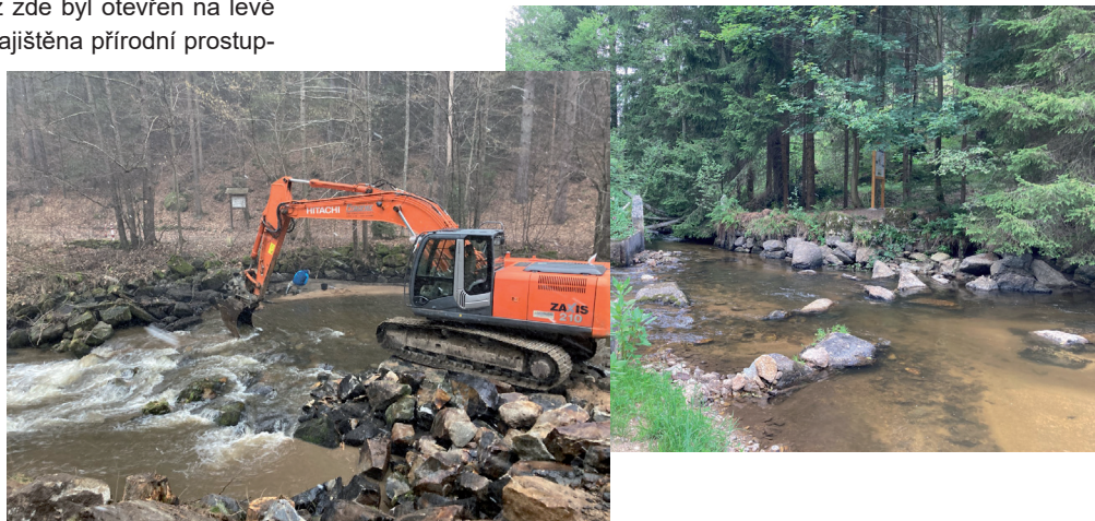
Horní Malše – odstranění příčných staveb (foto: Amt der OÖ. Landesregierung/Gewässerbezirk Linz)
