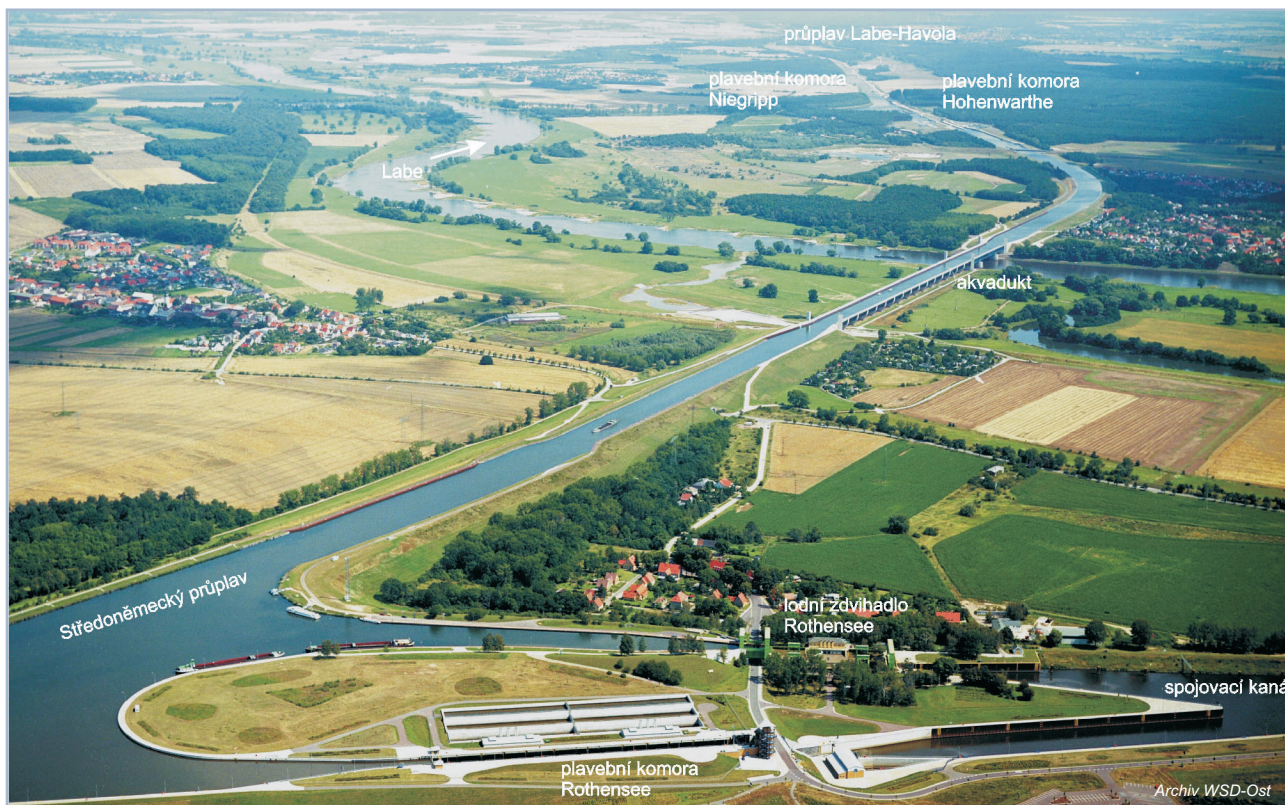
Obr. 4.8-20: Celkový pohled na křižovatku vodních cest u Magdeburku
