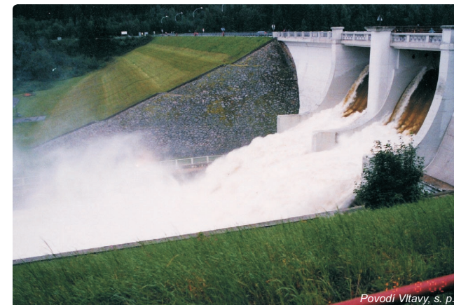
Obr. 3.3-12: 13. 8. 2002 bylo z nádrže Lipno I odpouštěno 320 \text{ m}^3 \cdot \text{s}^{-1}
