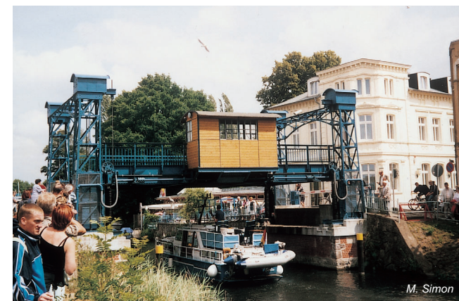
Obr. 4.10-12: Zdvižný most ve městě Plau
