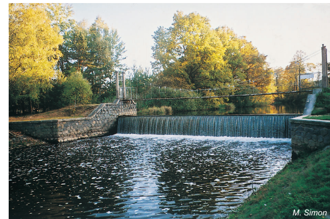
Obr. 4.2-15: Jez na Lužnici odvádějící vodu do Zlaté stoky
