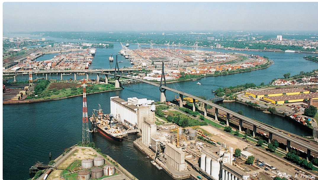
Obr. 4.11-10: Část Hamburského přístavu s mostem Köhlbrandhochbrücke
