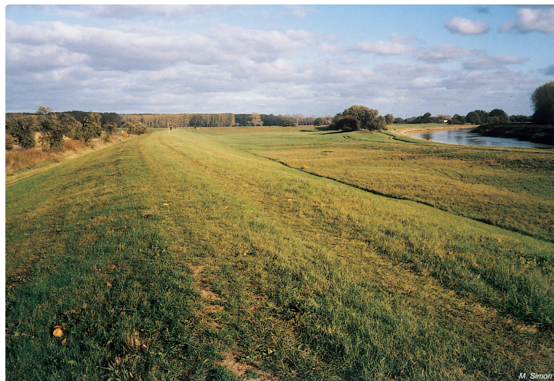
Obr. 3.1-13: Hráze proti zpětnému vzdutí na Sále nad soutokem s Labem
