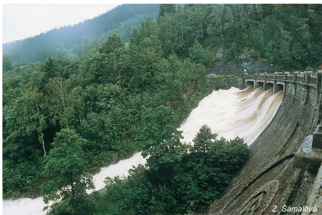
Obr. 3.3-9: Bezpečnostní přeliv přehrady Labská v červenci 1997
