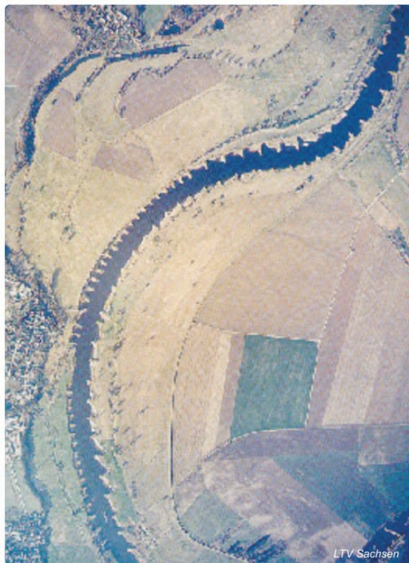
Obr. 4.4-26: Výhony na Labi u obce Belgern (ř. km 140)
