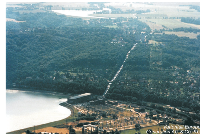
Obr. 4.4-20: Přečerpávací elektrárna Niederwartha
