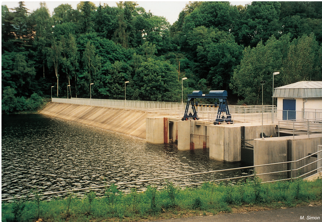
Obr. 4.3-8: Přehrada Skalka na Ohři
