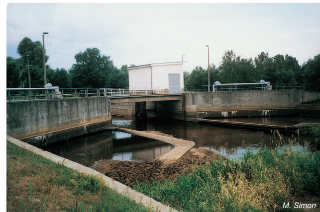
Obr. 4.5-9: Jez na Černém Halštrovu nad Senftenbergem včetně vtokových objektů do štoly, spojující vodní nádrže Koschen a Niemtsch
