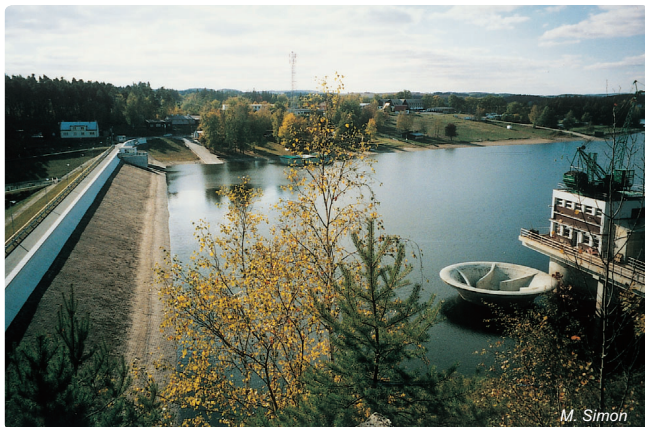
Obr. 4.2-25: Vodní nádrž Hracholusky s elektrárnou a šachtovým přelivem
