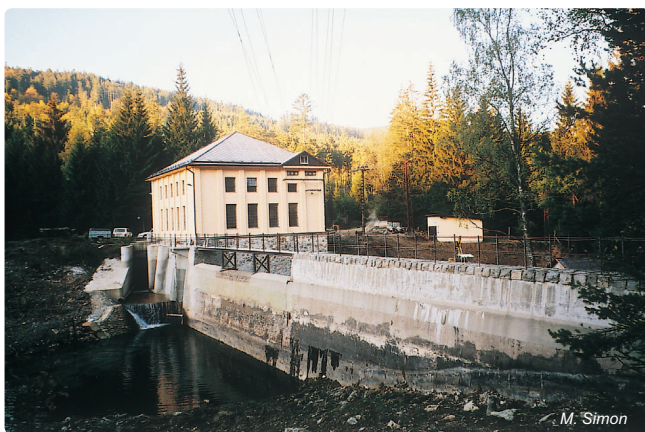
Obr. 4.2-26: Elektrárna a vyrovnávací nádrž přečerpávací elektrárny Černé jezero
