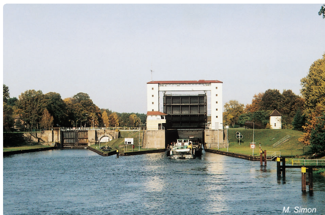
Obr. 4.9-9: Dvojité plavební komory u obce Lehnitz na průplavu Odra-Havola
