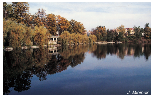
Obr. 4.2-16: Vodní nádrž Jordan (hráz včetně komunikace a v pozadí bezpečnostní přeliv)
