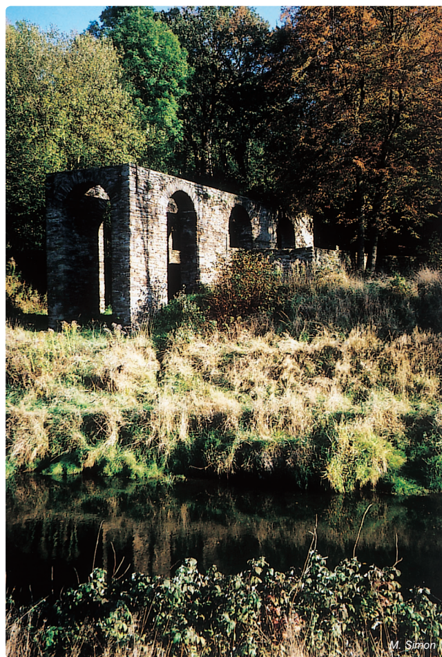
Obr. 4.6-10: Zbytky lodního zdvihadla Halsbrücke
