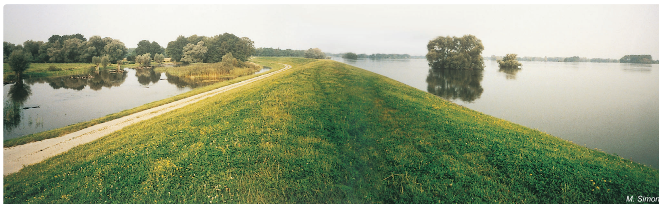
Obr. 3.1-15: Rekonstruovaná ochranná hráz na levém břehu Labe u obce Neukirchen (pod Werbenem – ř. km 436) s poldry na průsakové vody typickými v tomto úseku, 24. 8. 2002
