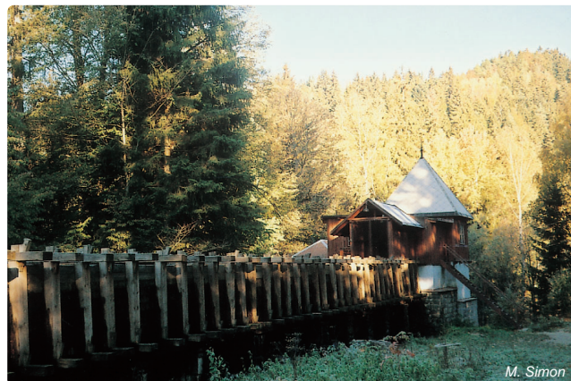
Obr. 4.2-18: Dřevěný 105 m dlouhý přívodní kanál k elektrárně Čeňkova pila
