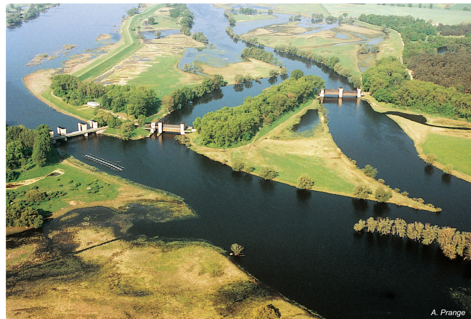
Obr. 4.9-37: Jezová soustava Quitzöbel - jez Neuwerben (vlevo), jez na odstaveném rameni a jez v průpichu na Havole
