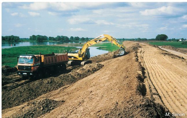
Obr. 3.1-14: Výstavba nové ochranné hráze na pravém břehu Labe u obce Jagel – ř. km 472 (Braniborsko) v roce 2003
