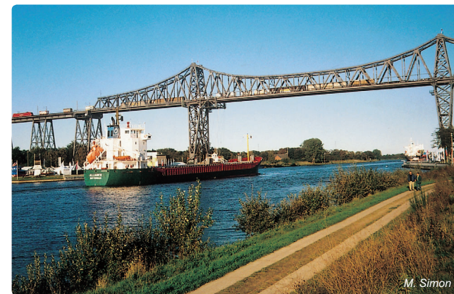
Obr. 4.11-15: Železniční most nad Severomořsko-baltským průplavem v Rendsburgu
