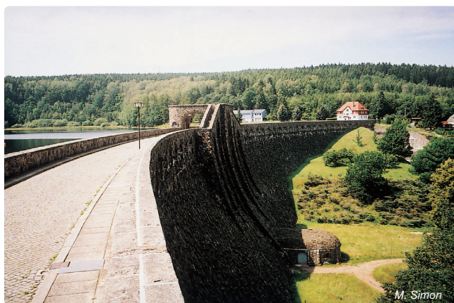
Obr. 4.4-19: Vodárenská nádrž Klingenberg na Divoké Bystřici
