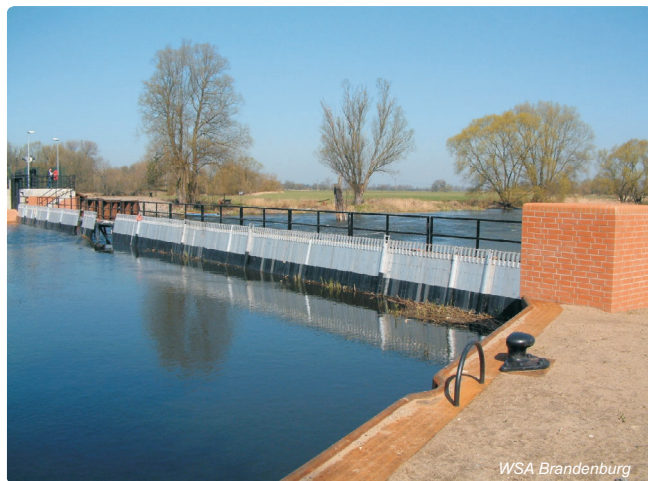
Obr. 4.9-35: Zrekonstruovaný hradlový jez Garz
