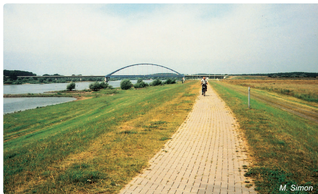
Obr. 4.10-18: Rekonstruovaná ochranná hráz na Labi nad novým mostem ve městě Dömitz
