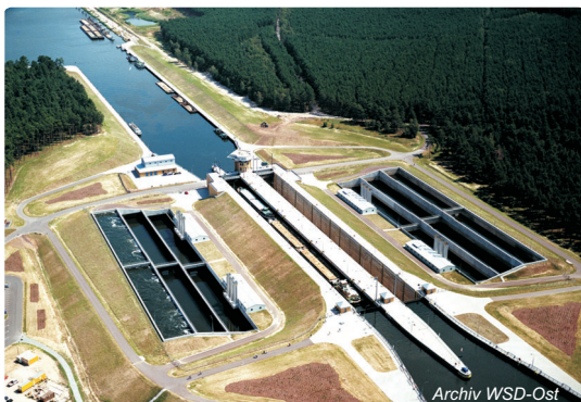
Obr. 4.8-22: Dvojitá plavební komora Hohenwarthe s úspornými nádržemi
