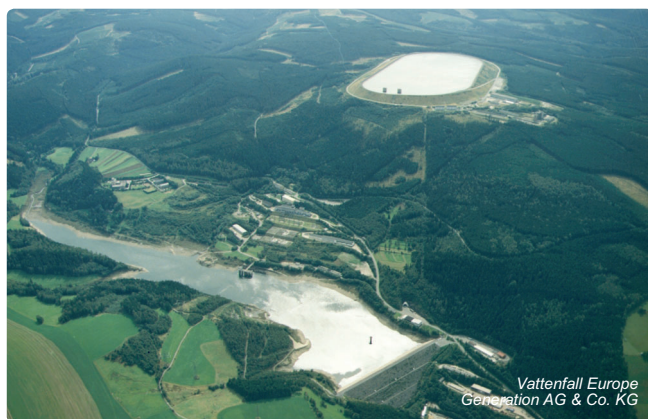
Obr. 4.6-20: Přečerpávací elektrárna Markersbach
