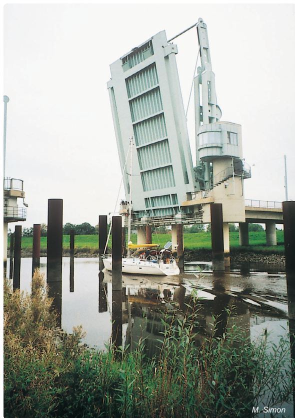
Obr. 4.11-6: Sklápěcí most přes řeku Schwinge na silnici 1. třídy č. 495 u Stade
