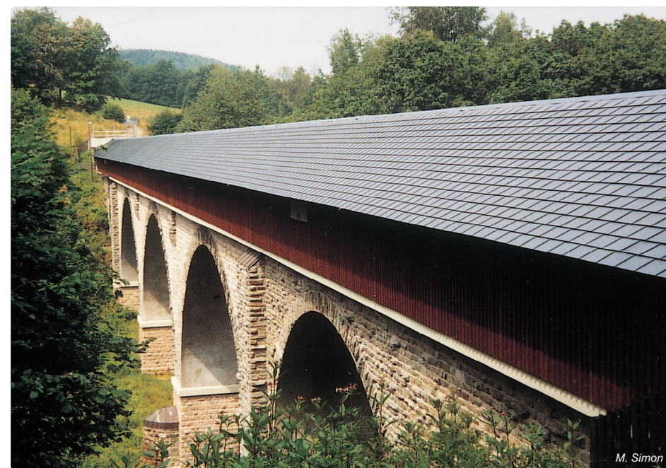
Obr. 4.6-8: Zrekonstruované přemostění převaděče přes řeku Zschopau u obce Waldkirchen
