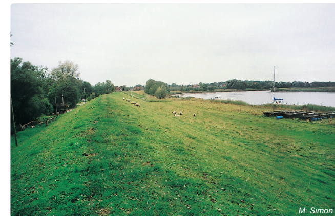
Obr. 3.1-10: Hráz na přítoku Oste u obce Neuhaus nad ochranným uzávěrem proti bouřlivým přílivům
