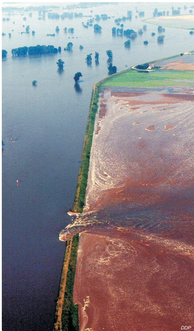
Obr. 4.4-23: Protržená hráz u obce Dautzschen při povodni v srpnu 2002
