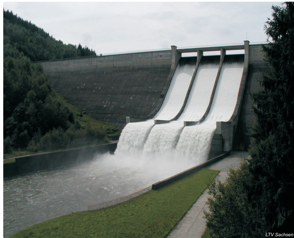
Obr. 3.3-16: Odvádění povodňové vlny z nádrže VD Eibenstock dne 13. 8. 2002 (55 m 3 .s -1 )
