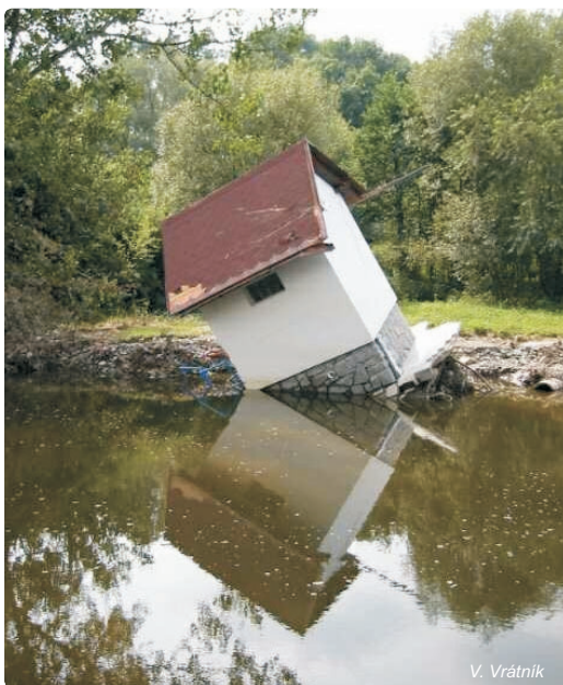
Obr. 5.1-14: Zničená vodoměrná stanice Ždírec na Úslavě v povodí Berounky
