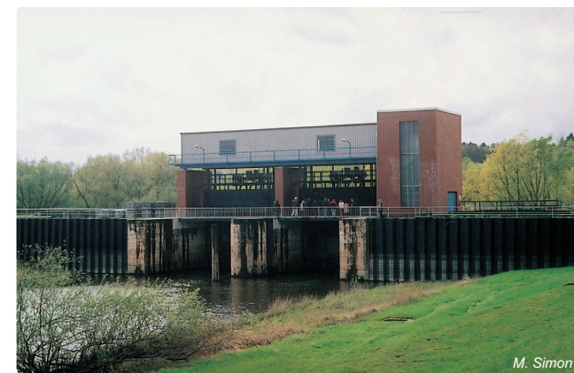
Obr. 3.1-17: Uzavírací jez v oblasti ústí řeky Sude
