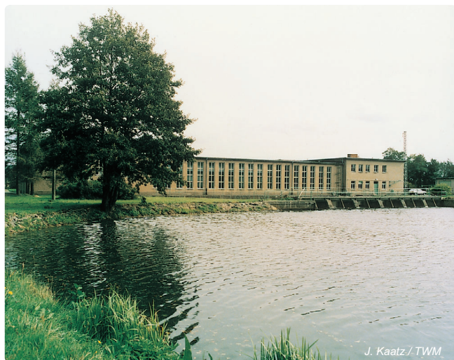
Obr. 4.8-27: Čerpací stanice Satuelle a příslušná přivodní nádrž (35 000 m 3 )
