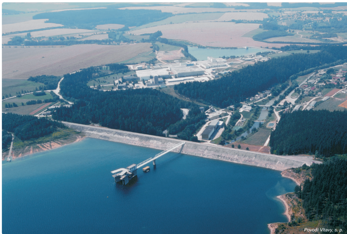
Obr. 4.2-21: Vodárenská nádrž Švihov na Želivce
