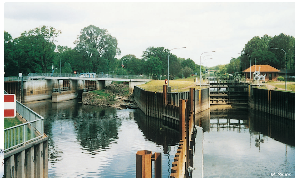
Obr. 4.10-16: Zdymadlo Dömitz včetně plavební komory, jezu a rybního přechodu
