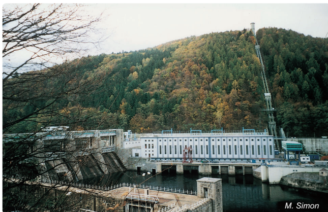
Obr. 4.2-12: Vodní nádrž Štěchovice s průtočnou elektrárnou (vlevo) a přečerpávací elektrárnou (vpravo)
