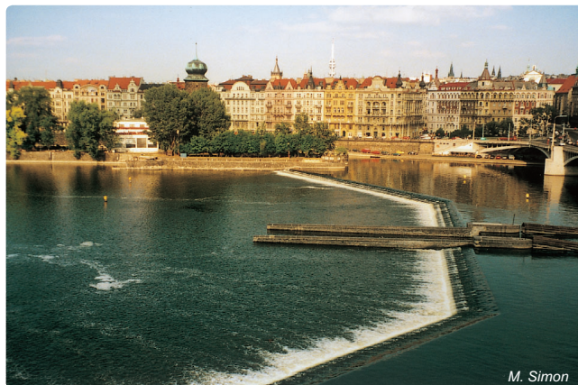
Obr. 4.2-27: Šítkovský jez s vorovou propustí, plavební komorou a středověkou vodárenskou věží Mánes v pozadí
