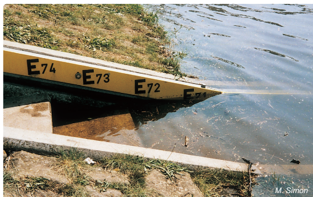
Obr. 5.1-9: Schodišťový vodočet na vodoměrné stanici Wittenberge na Labi při vodním stavu 714 cm. Nejvyššího vodního stavu – 734 cm – zde bylo dosaženo 20. srpna 2002.
