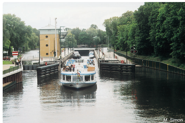
Obr. 4.9-10: Plavební komora na Havole v berlínské městské části Spandau
