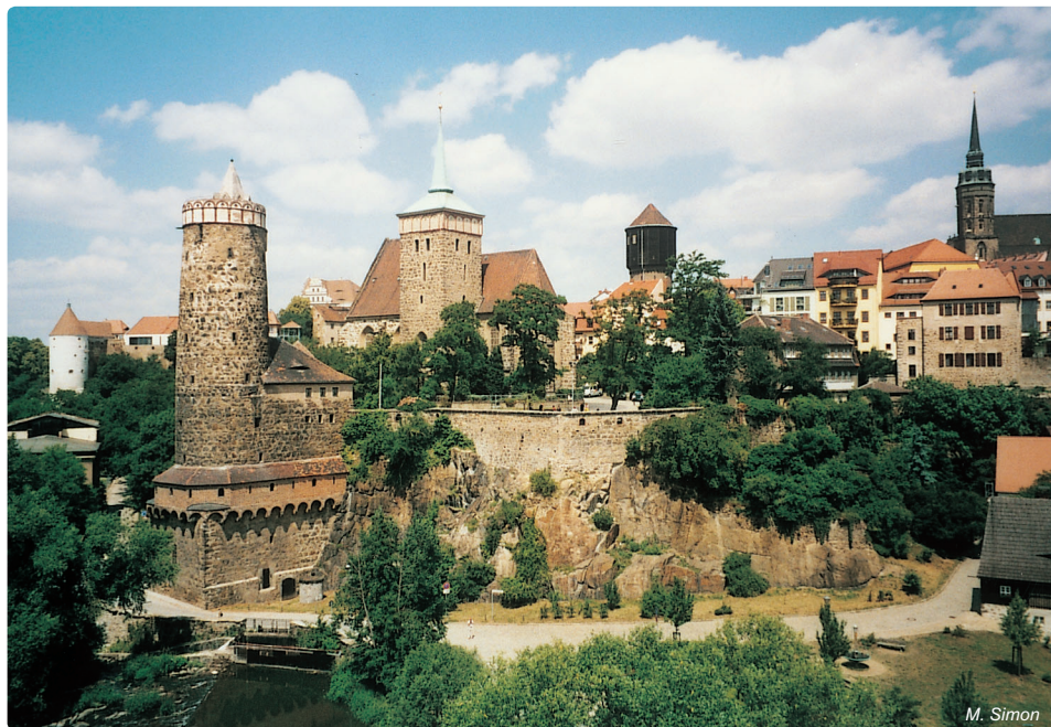
Obr. 4.9-13: Pohled na historickou část města Bautzen s jezem na Správě a vodojemem Alte Wasserkunst (levá vysoká věž městského opevnění)
