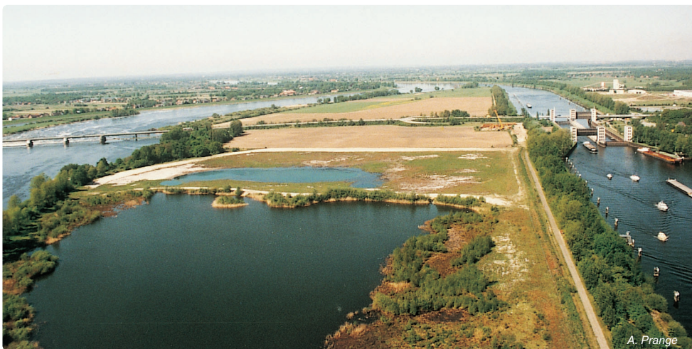
Obr. 4.10-22: Zdymadlo Geesthacht včetně jezu (vlevo) a plavebních komor
