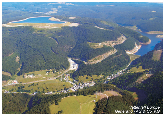
Obr. 4.7-9: Přečerpávací elektrárna Goldisthal
