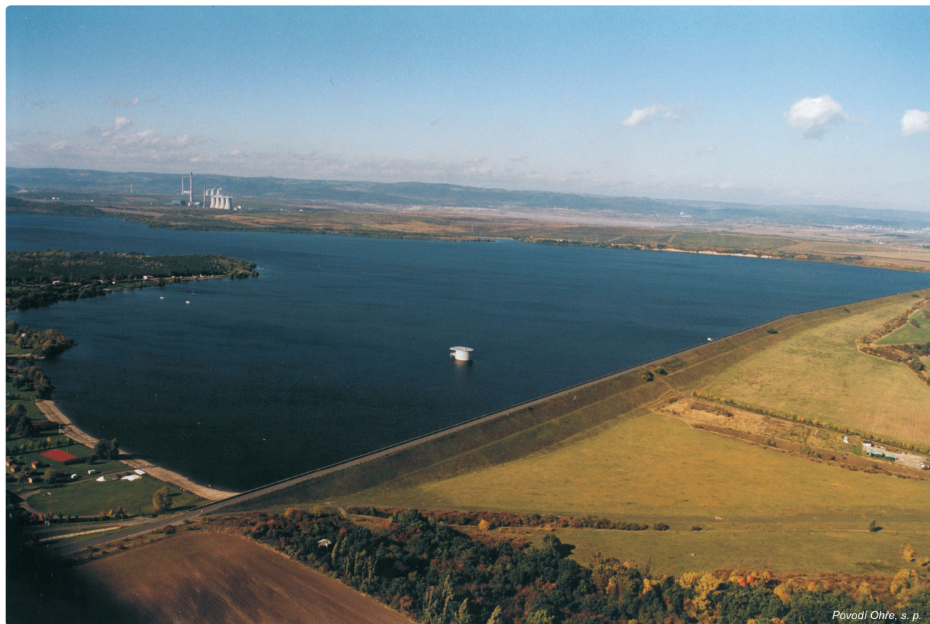
Obr. 4.3-10: Přehrada Nechranice na Ohři
