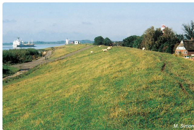
Obr. 3.1-4: Pravá ochranná hráz Labe u obce Kollmar pod soutokem s řekou Krückau
