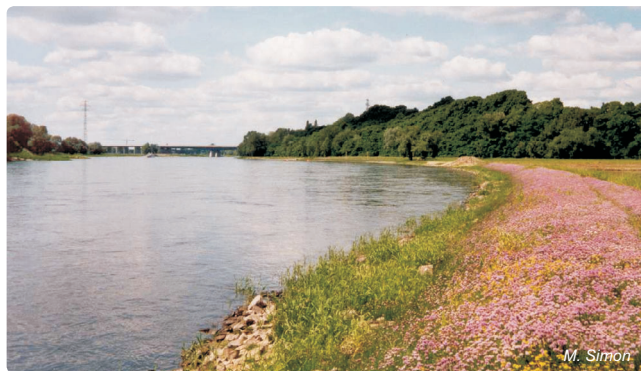
Obr. 4.4-27: Opevnění svahu konkávního břehu Labe u Lostau pod Magdeburkem
