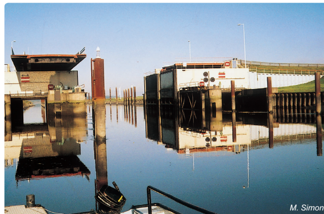
Obr. 3.1-9: Ochranný uzávěr proti bouřlivým přílivům na řece Pinnau s plavebními a dvěma postranními otvory
