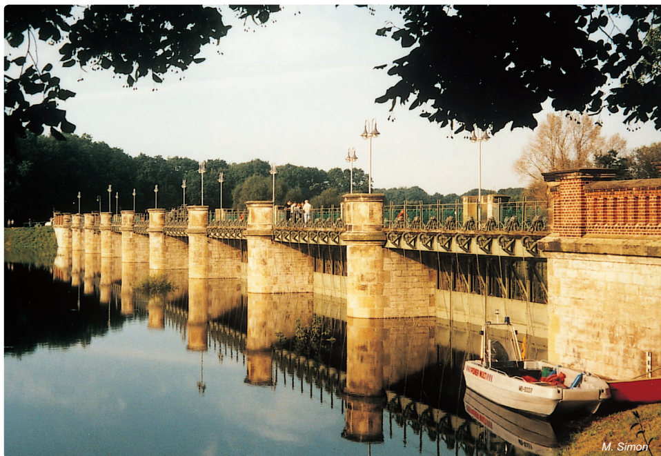
Obr. 4.8-13: Tabulový jez na obtokovém kanálu Labe v Pretzienu
