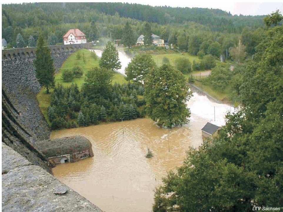
Obr. 3.3-15: Odvádění povodňové vlny z nádrže VD Klingenberg dne 13. 8. 2002 (170 m 3 .s -1 )
