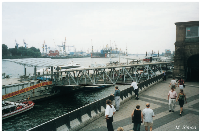
Obr. 3.1-6: Protipovodňová zeď v Hamburku v přístavišti St. Pauli Landungsbrücken
