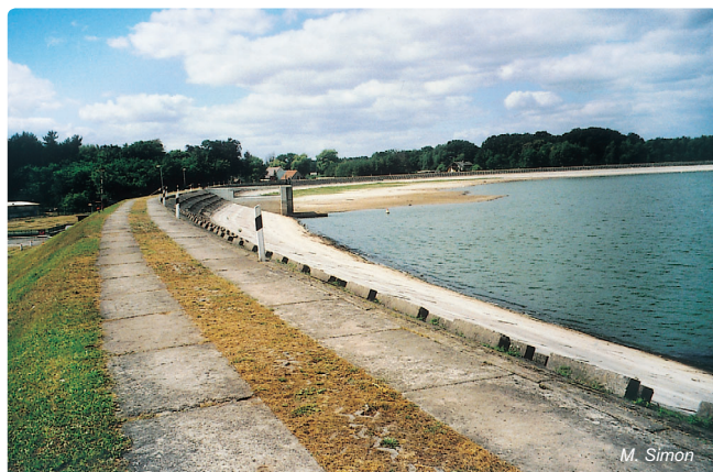
Obr. 4.9-36: Hlavní hráz nádrže Dossespeicher Kyritz a odběrný objekt
