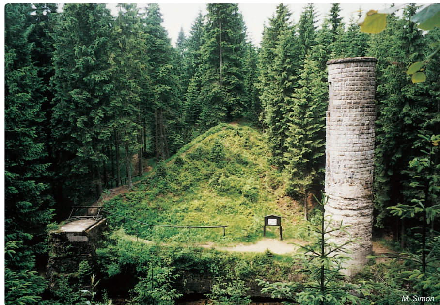
Obr. 4.1-18: Zbytky zemní hráže přehrady Bílá Desná, zničené v roce 1916, včetně spodní výpusti se šoupátkovou šachtou a výtokového objektu
