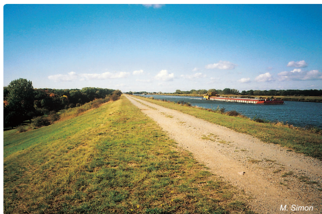
Obr. 4.8-19: Násypový úsek Středoněmeckého průplavu západně od Labe
