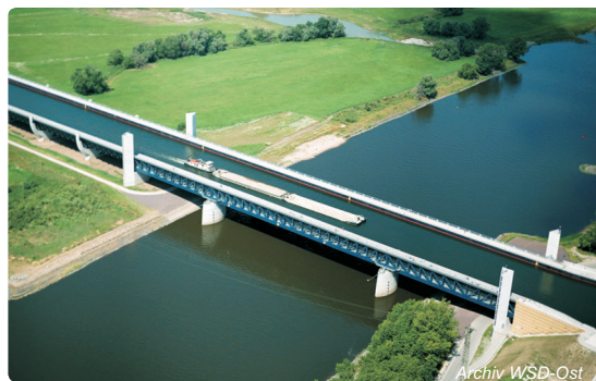
Obr. 4.8-21: Akvadukt přes Labe u Hohenwarthe
