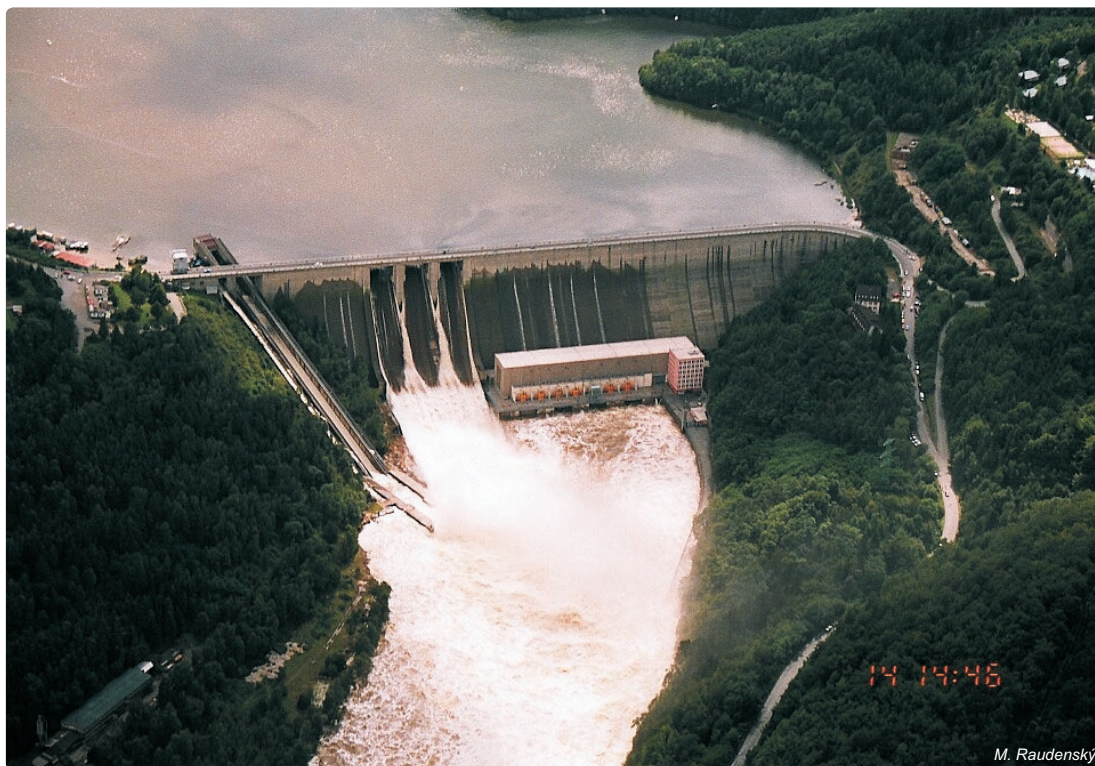
Obr. 3.3-11: 14. 8. 2002 bylo z nádrže Orlík odpouštěno 3\,100\text{ m}^3\cdot\text{s}^{-1}
