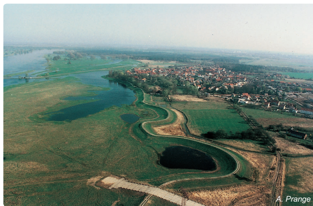
Obr. 3.1-11: Trasa hrázové linie u města Sandau (ř. km 415) s jasně identifikovatelnými lokalitami bývalých průtrží hrází
