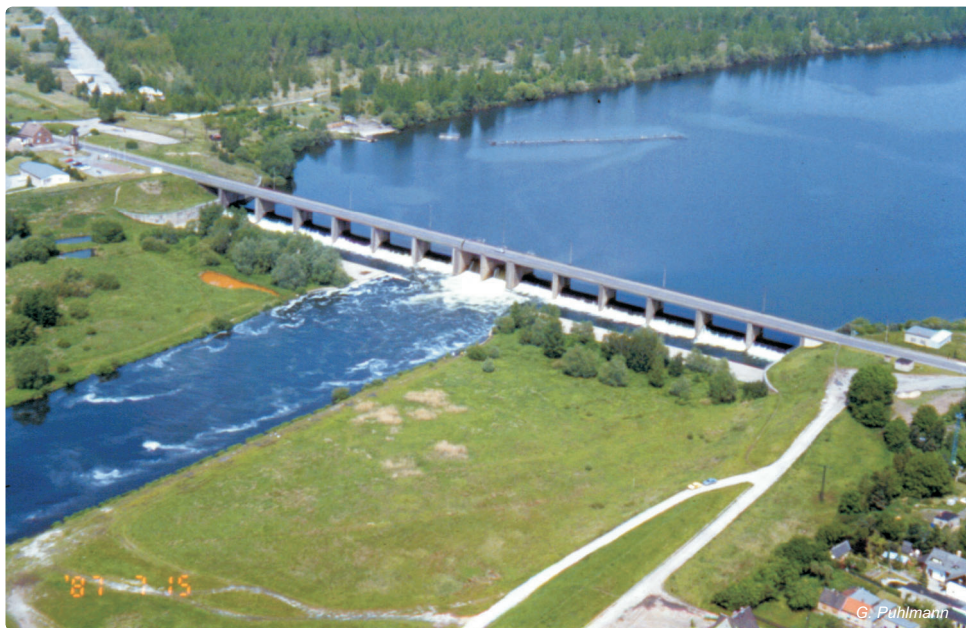
Obr. 4.6-27: Výtokový objekt vodní nádrže Muldestausee
