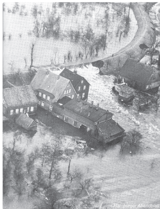
Obr. 3.1-1: Protržená ochranná hráz u Hamburku-Neuenfelde během bouřlivého přílivu dne 17. února 1962
