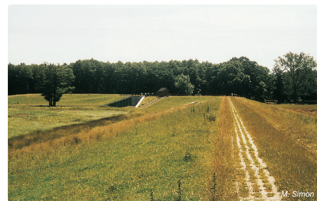
Obr. 4.10-4: Retenční nádrž Neue Mühle na toku Stepenitz
