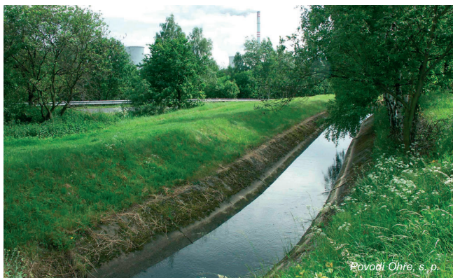
Obr. 4.3-13: Průmyslový přivaděč Ohře - Bílina a elektrárna Prunéřov 2 v pozadí
