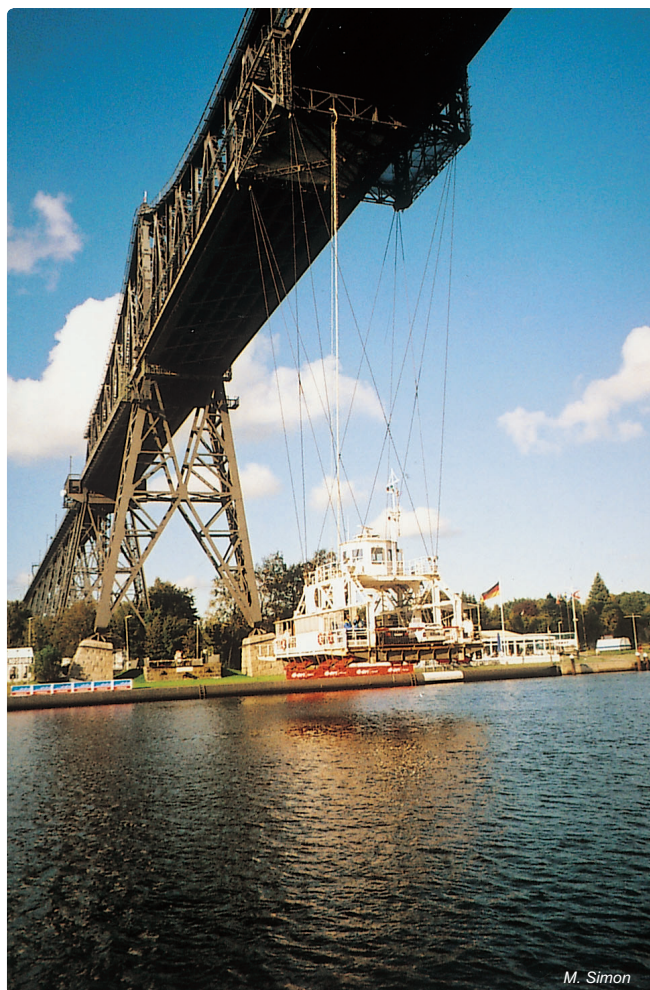
Obr. 4.11-16: Visutý přívoz na železničním mostě v Rendsburgu
