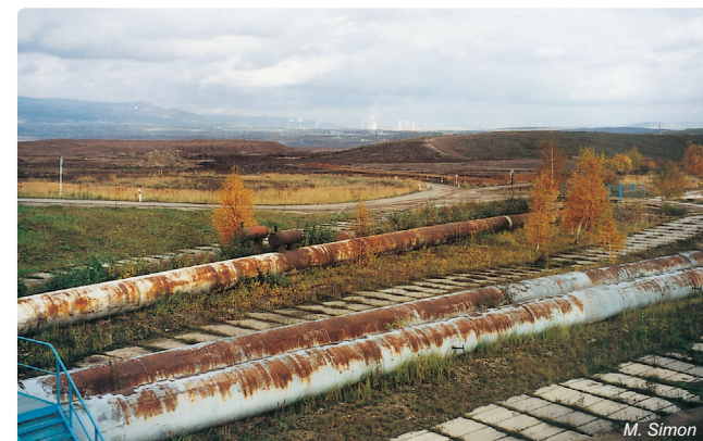
Obr.: 4.3-11: Bílina převedená potrubím s pohledem na rozsáhlý povrchový důl ČSA
