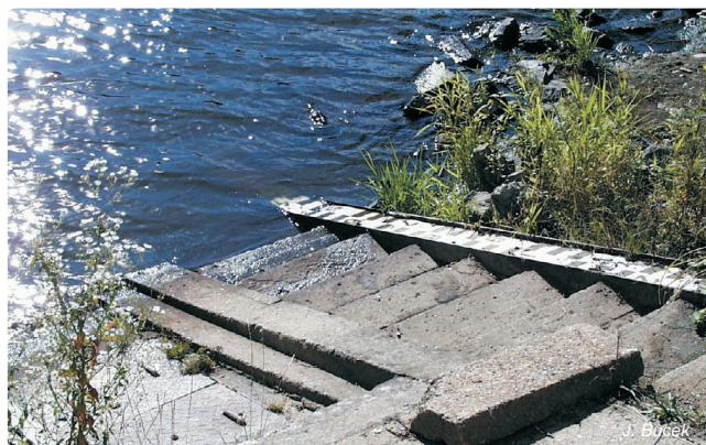
Obr. 5.1-8: Šikmý vodočet v Praze-Chuchle na Vltavě
