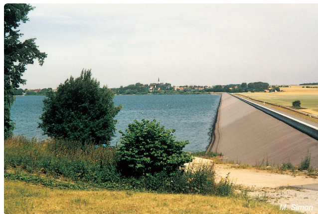
Obr. 4.9-14: Hlavní hráz přehrady Bautzen
