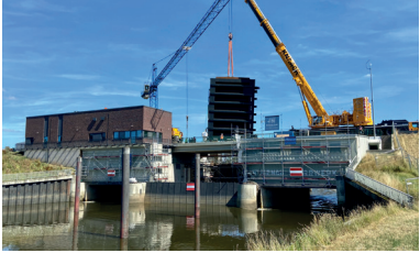
Zabudování vzpěrných vrat na ochranném uzávěru proti bouřlivým přílivům na toku Ilmenau – foto: Stefan Löhn, NLWKN
