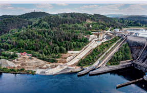
Stavba doplňkového bezpečnostního přelivu vodního díla Orlík (vlevo) a vizualizace finální podoby (vpravo) – foto: Povodí Vltavy, státní podnik
