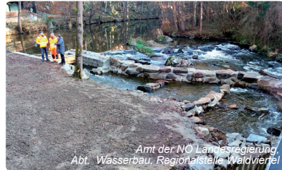
Fischwanderhilfe an der Wehranlage Mahlerwinkel im Braunaubach
