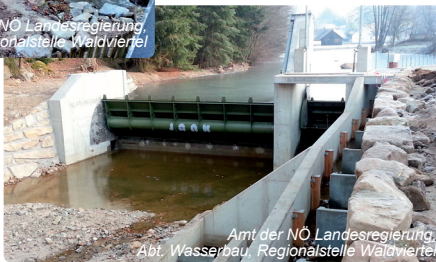
Fischwanderhilfe Pichlerwehr im Braunaubach
