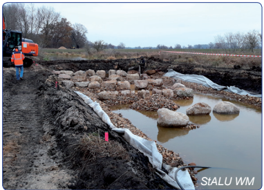
Bau der Fischaufstiegsanlage Schultenberg
