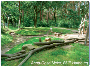
Muldenversickerung und Stauraumnutzung auf dem Regenwasserspielplatz „Neugraben-Fischbek“
