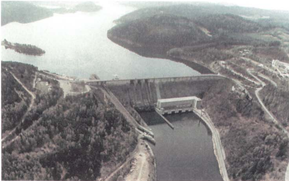
Die Talsperre Orlický in der Moldau ist mit einem Gesamtstauraum von 716,5 Mio. m 3 und einem gewöhnlichen Hochwasserrückhalte-raum von 62,0 Mio. m 3 eine Schlüsseltalsperre in der Moldaukaskade.
