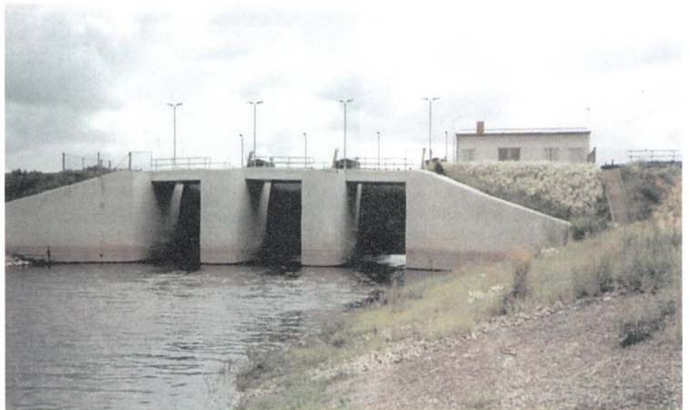
Pretziener Wehr. Bei höheren Hochwassern werden bis zu 20 % des Scheiteldurchflusses der Elbe bei Barby über einen 29 km langen Umflutkanal um Magdeburg herumgeleitet. (K. Wecke)
