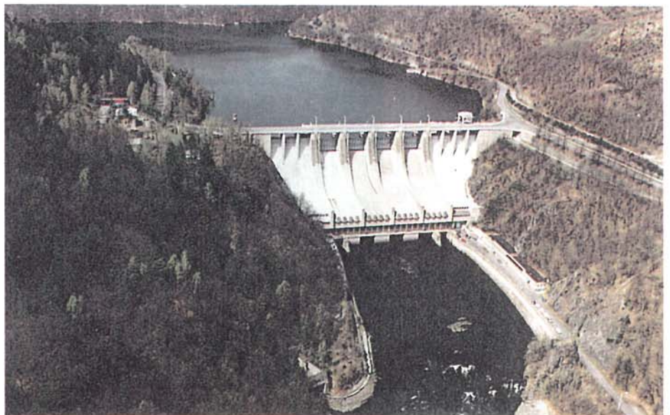
Talsperre Slapy in der Moldau mit einem Gesamtstauraum von 269,3 Mio. m 3 und einem gewöhnlichen Hochwasserrückhalte-raum von 17,1 Mio. m 3 .
