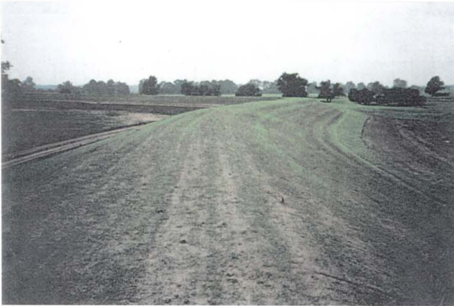
Sanierter 5 m hoher Elbedeich bei Beuster (Bundesland Sachsen-Anhalt) mit Rollrasenandeckung am wasserseitigen Deichfuß. Deichverteidigungsweg auf der Landseite.
