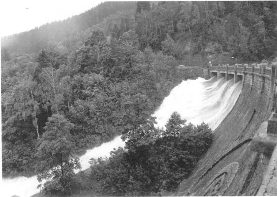
Talsperre Labská in Špindlerův Mlýn (Riesengebirge). Gesamtstauraum 3,0 Mio. m 3 , davon 1,1 Mio. m 3 gewöhnlicher Hochwasserrückhalteraum. Hochwasserüberlauf am 07.07.1997. (Z. Šámalová)
