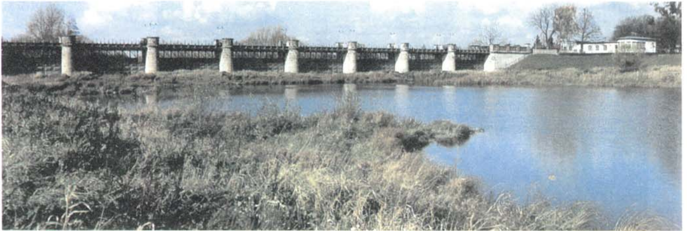
Pretziener Wehr. Bei höheren Hochwassern werden bis zu 20 % des Scheiteldurchflusses der Elbe bei Barby über einen 29 km langen Umflutkanal um Magdeburg herumgeleitet. (K. Wecke)
