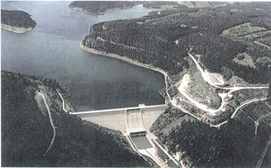
Talsperre Eibenstock an der Zwickauer Mulde (Erzgebirge) mit einem Gesamtstauraum von 74,65 Mio. m 3 und einem gewöhnlichen Hochwasserrückhalte-raum von 3,25 Mio. m 3 .
