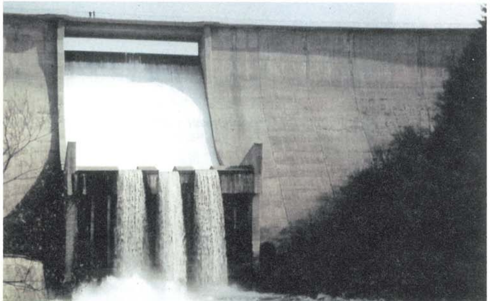
Talsperre Pöhl an der Trieb (Vogtland) mit einem Gesamtstauraum von 61,98 Mio. m 3 und einem gewöhnlichen Hochwasserrückhalte- raum von 5,06 Mio. m 3 . Hochwasserüberlauf am 06.05.1980 in Funktion
