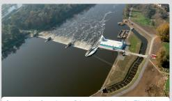
Construction of a rock ramp fishpass at the Lovosice Elbe Weir Photo: Povodí Labe, státní podnik
