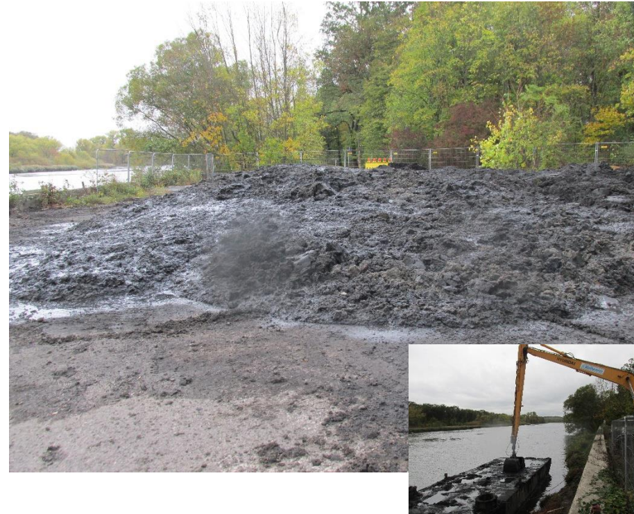
Sedimente Beräumung Elsterbecken Quelle: LTV, 2018
