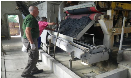
WWTP Oleochem, a.s. Ústí nad Labem-Střekov
