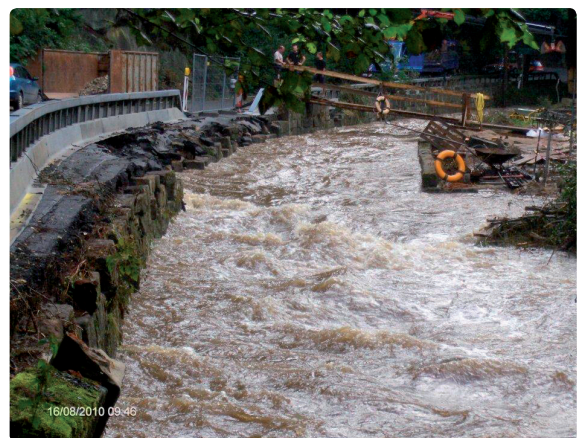
Abb. 3.3.3: Zerstörungen im Kirnitzschtal nach dem Hochwasser am 07.08.2010 - Quelle: LTV
