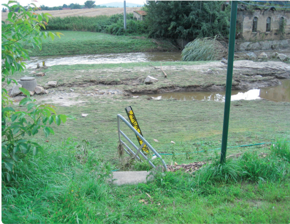
Abb. 3.7.2: Zerstörtes Pegelprofil Bautzen-Weite Bleiche an der Spree im August 2010 - Quelle: BFUL
