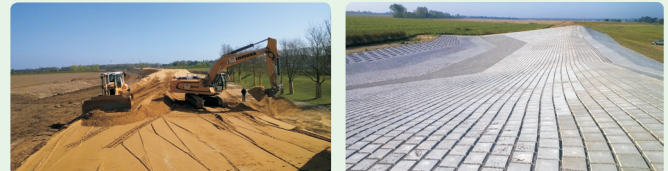
Stavba nové ochranné hráze (vlevo) a přelivný práh (vpravo) – Foto: LAU Brandenburg
