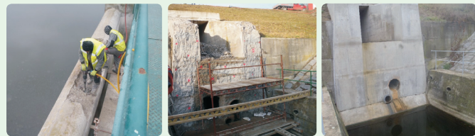
Bourání přelivných hran bezpečnostního přelivu (vlevo), práce na výtokovém portálu (uprostřed), výtokový portál po dokončení (vpravo) – Foto: Povodí Labe, státní podnik
