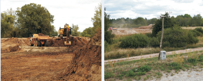
Oddálení hráze od toku v lokalitě Sandau-sever: otevření staré hráze (vlevo) a skládka materiálu z otevření staré hráze (vpravo) – Foto: MULE ST
