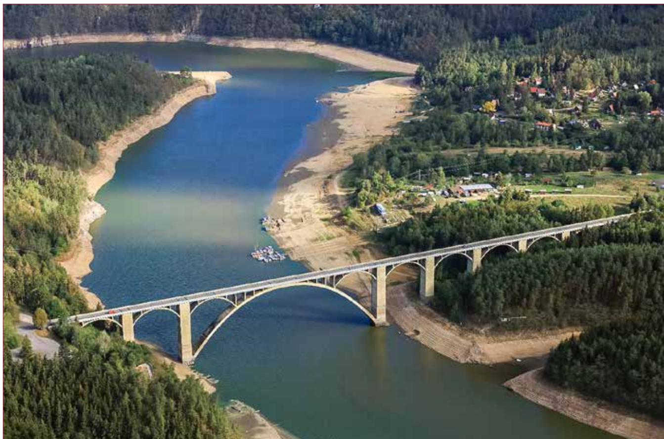
Fig. 1: Orlík water work – Podolský bridge – 20150927
